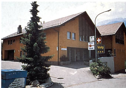
Das Geschäftshaus «Malin» in Trimmis beherbergt nebst VOLG-Laden, Post, Wohnungen und den Büros des LBA Trimmis auch die örtliche Raiffeisenbank.
