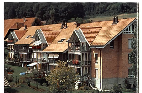
Wohn- und Gewerbeüberbauung «Brünmatt» in Meikirch BE.
