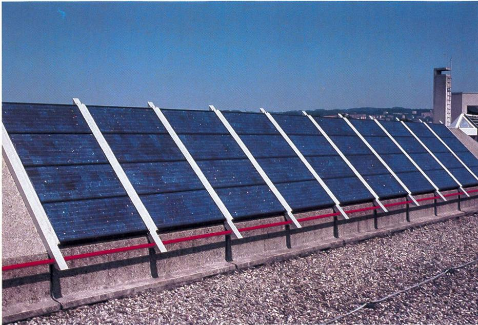
**Integration der photogalvanischen Architektur: Installation von 3 KW, am Netz angeschlossen und auf ein Dach der ETH Lausanne montiert.**
