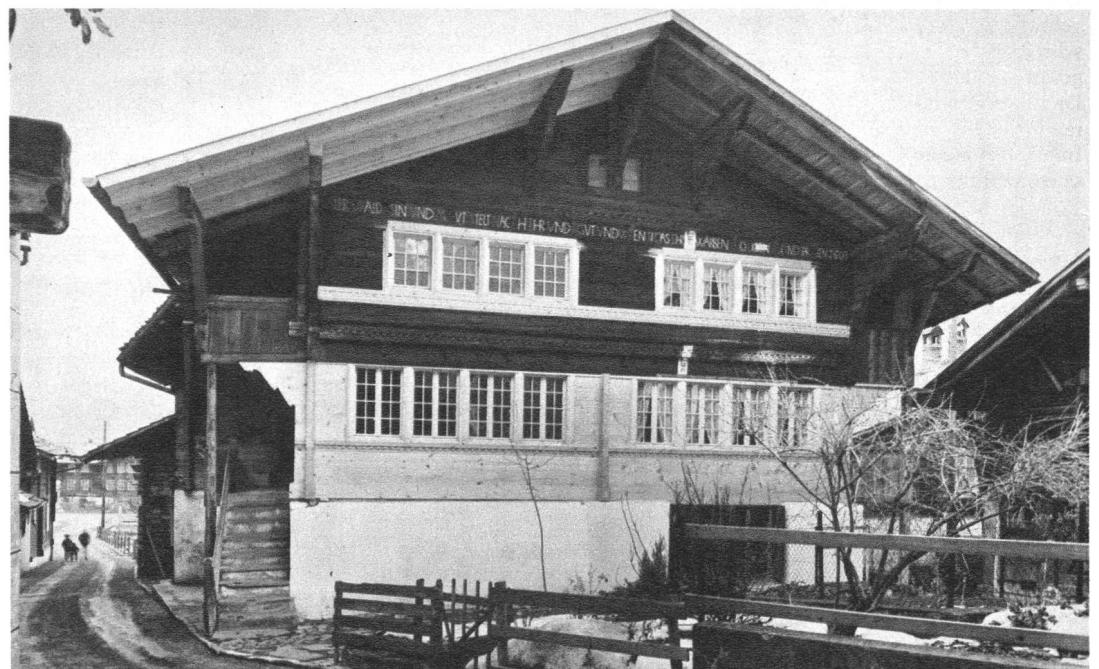
Haus in Bönigen am Brienzersee aus dem Jahre 1603: Auch an diesem Haus finden wir alle typischen Merkmale eines Chalets: Weitaufladendes Dach, markante Blockkonsolen unter den Dachpfetten, Zierleisten, Inschriften, seitliche Lauben und relativ kleine Fenster mit feiner Sprosseneinteilung.
