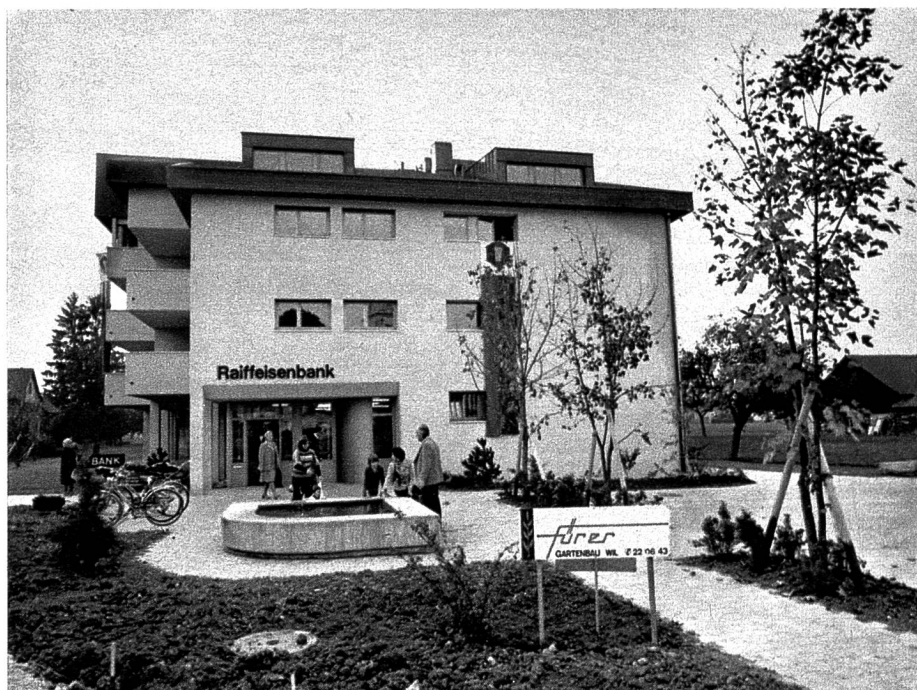
Neubau der Raiffeisenbank Oberbüren
