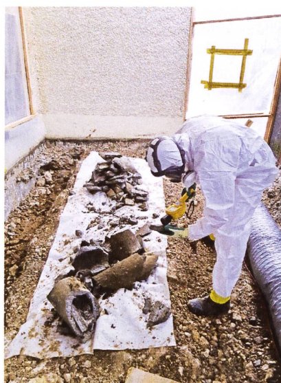
Figur 2: Dekontaminierungsarbeiten auf einer mischkontaminierten Parzelle.
