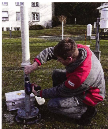
Figur 6: Alte Sonde wird ausgebaut.
