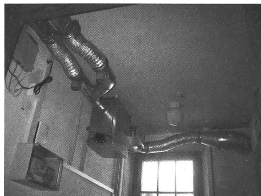
Figur 13 Ventilator und Steuerung in Nebenraum des Kindergartens
