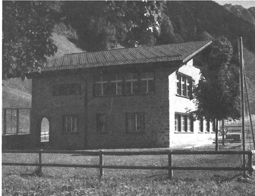
Figur 10 Schulgebäude im Kanton Graubünden
