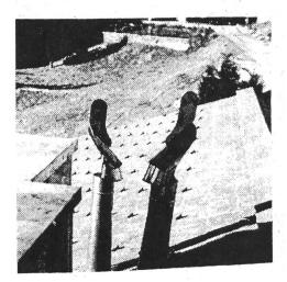
Abb. 1: Ein Röhrensystem unter dem Haus soll das Radon im Boden sammeln und via Kamin in die Atmosphäre führen.
