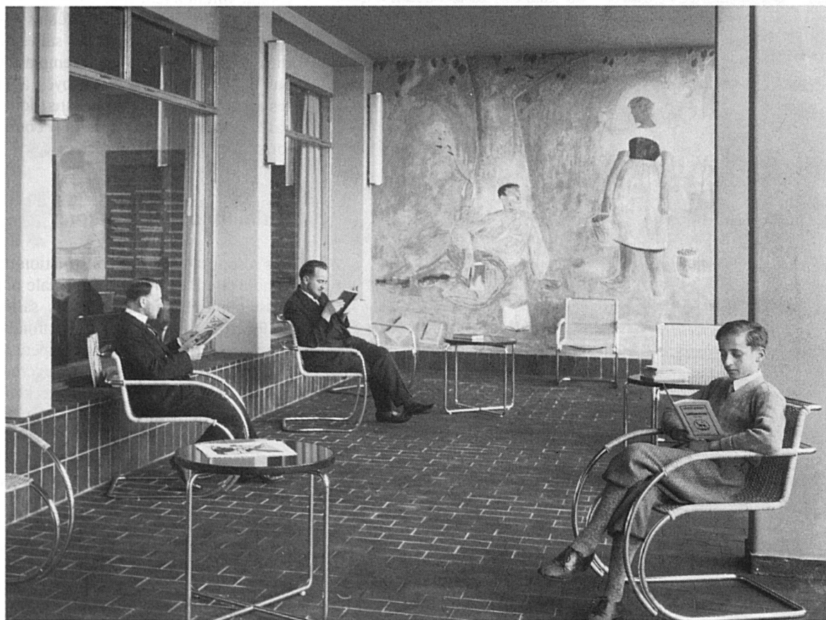
Terrasse de la salle de lecture pourvue de mobilier tubulaire (été 1932).
