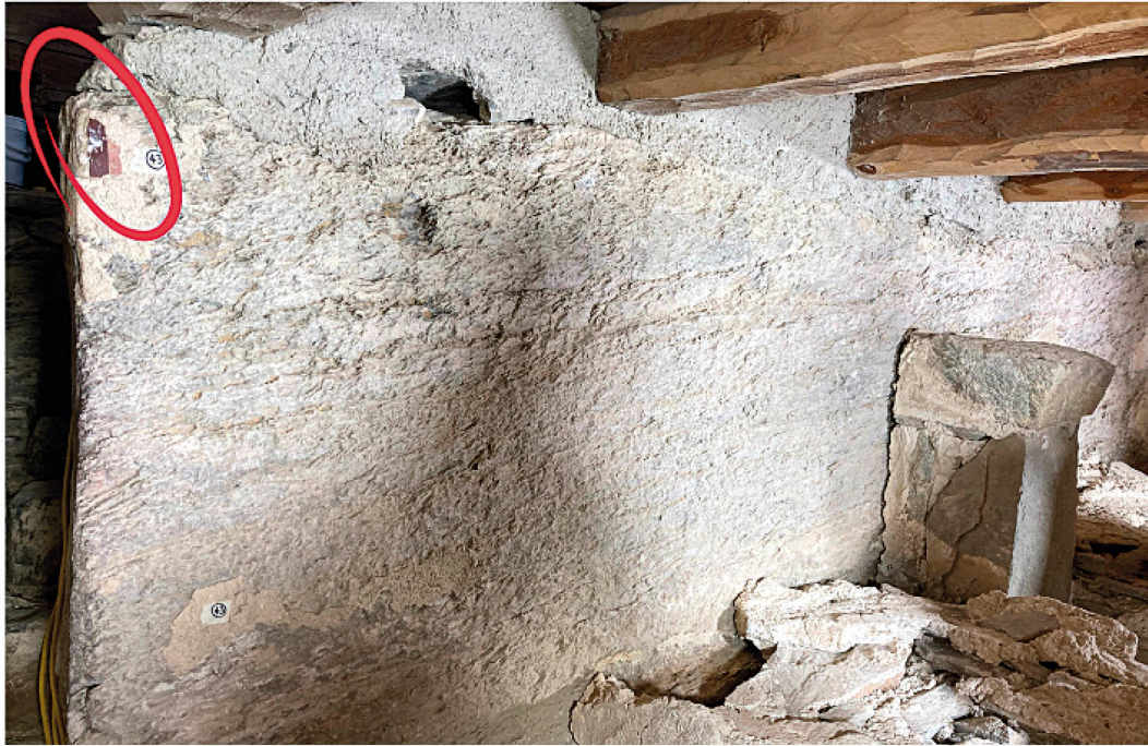
Figura 4. La parete su cui si estendevano le due raffigurazioni ritrovate da Sulser. Si può notare sull'angolo a sinistra in alto un residuo di pittura muraria. La colonna a destra fungeva da appoggio della volta crollata
