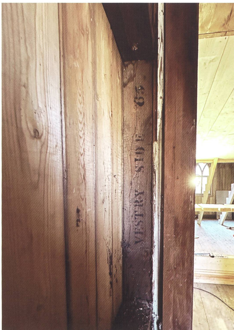
[G] La scritta «Vestry side 65» indica la posizione della tavola di legno nell'insieme della costruzione. Per gentile concessione di magma / VeronesiHöpflinger
