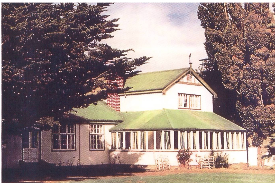
Casa di residenza per la «Estancia Güer Aike», realizzata nel 1915 nei cantieri di Humphreys a Londra (sopra) e poi trasportata in Argentina, nella provincia di Santa Cruz. L'edificio si trova ancor oggi in ottime condizioni. Per gentile concessione di Silvia Mirelman
