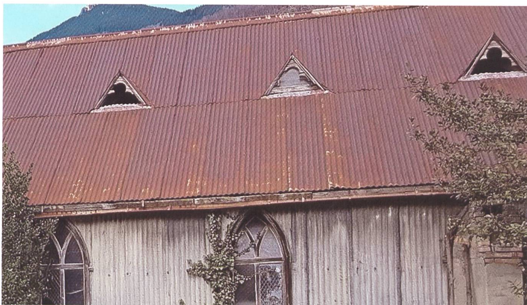
[E] Il tetto (lato nord) con le sue aperture di ventilazione. Fotografia dell'autrice
