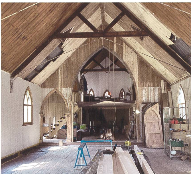
L'interno del "tabernacolo di latta" di Roveredo, prima e dopo i lavori di ristrutturazione. Per gentile concessione di magma / VeronesiHöpflinger
