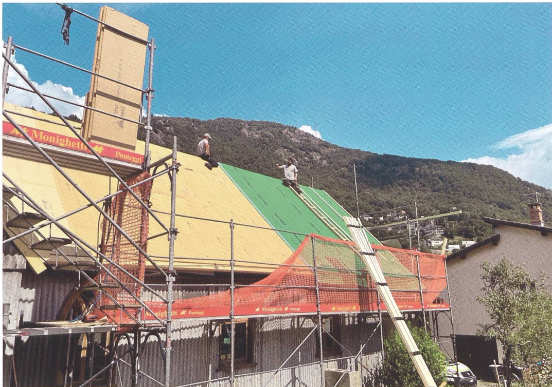
Autunno 2024: dopo centoundici anni, si provvede alla sostituzione del tetto. Per gentile concessione di magma / VeronesiHöpflinger
