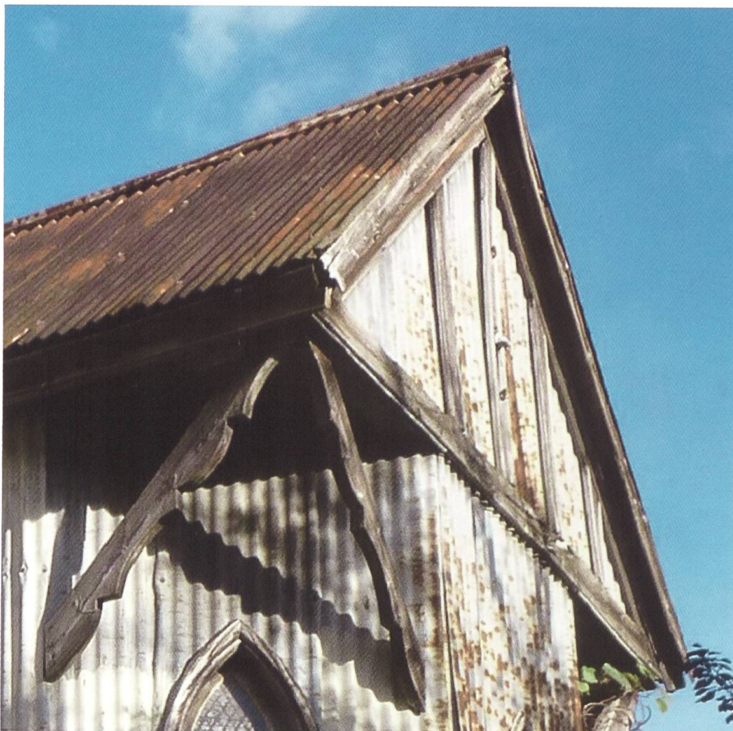
[F] L'estensione del tetto sopra l'abside. Fotografia dell'autrice
