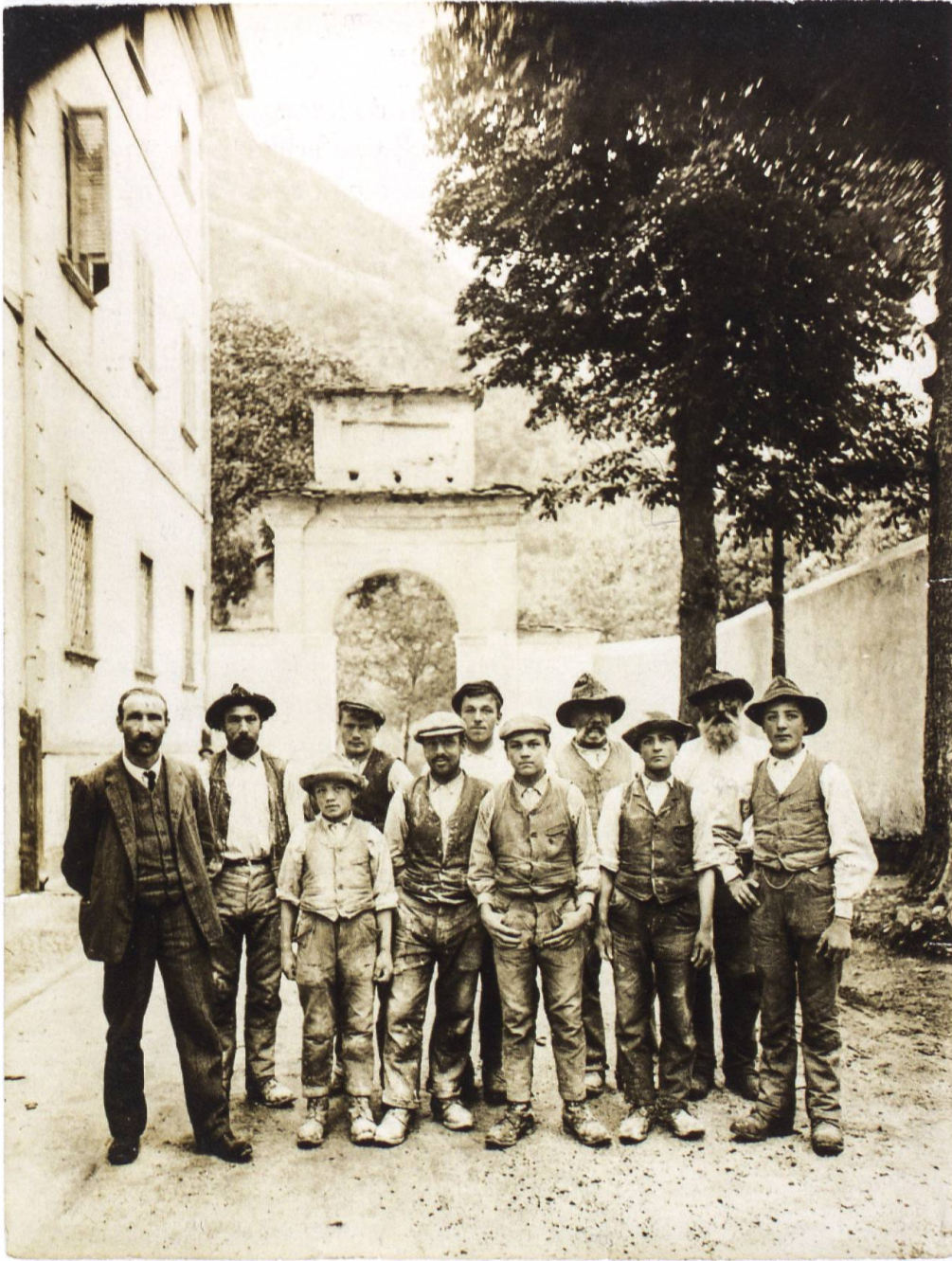
Ottavio Ganzoni insieme a muratori, tagliapietre e garzoni presso Palazzo Salis a Bondo, 1909. Fonte: Archivio di Stato dei Grigioni – Coira
