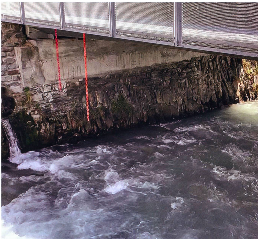
Ponte di Cimavilla, la spalla del ponte mostra l'inadeguata altezza prima dell'alluvione del 1987. Foto: F. Iseppi
