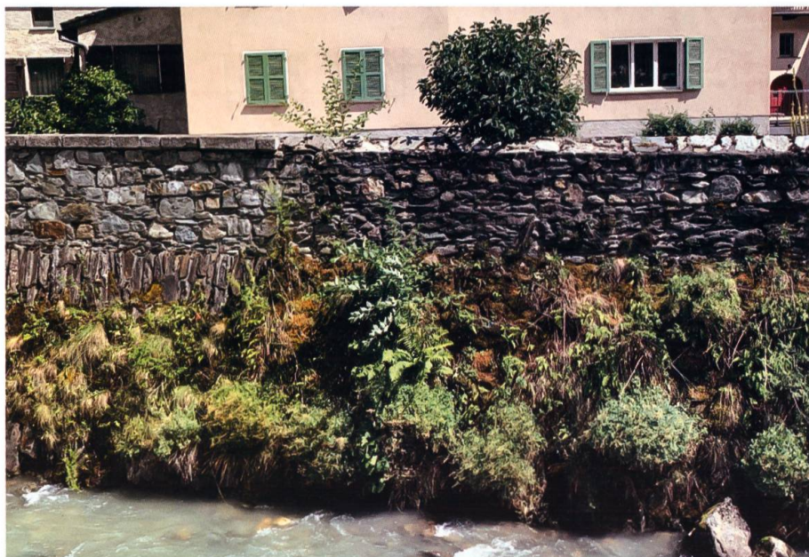
Ricoperta in parte dalla vegetazione, la muratura dell'argine presenta interventi di età diversa. Foto: F. Iseppi
