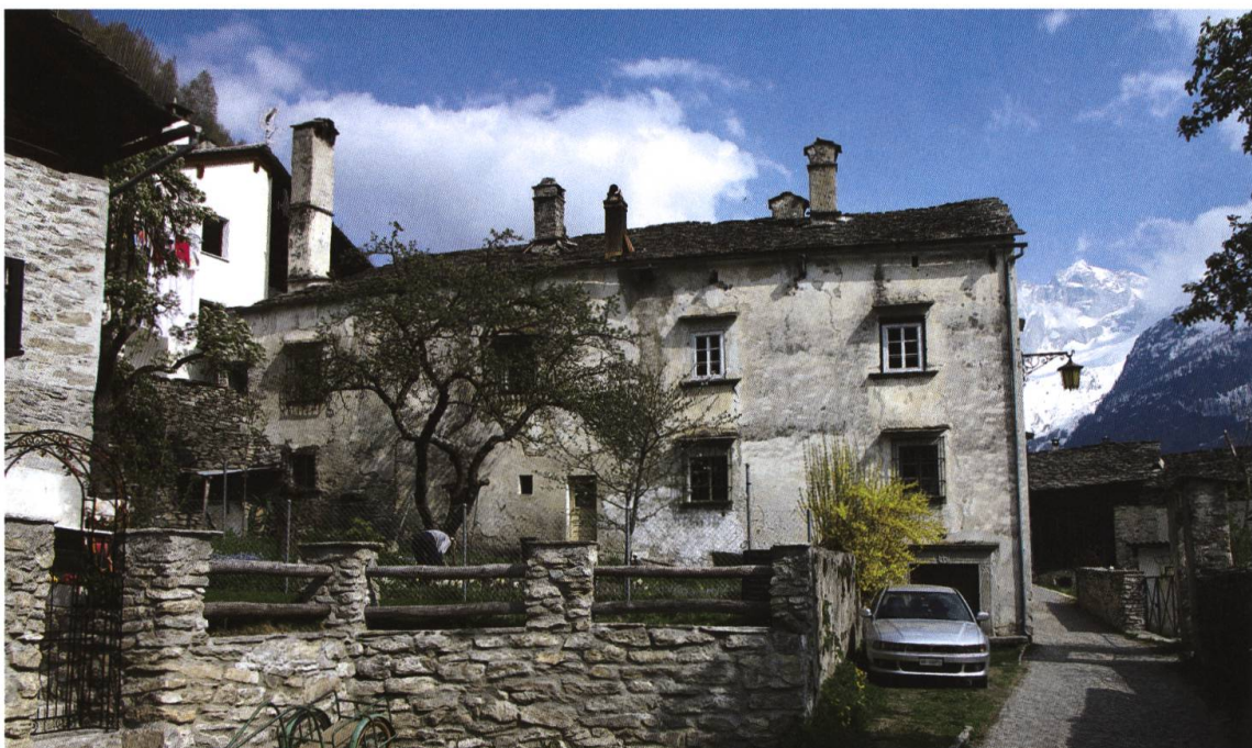
[2] Casa Guberto, vista da ovest. Foto: DPG/SMG 2019
