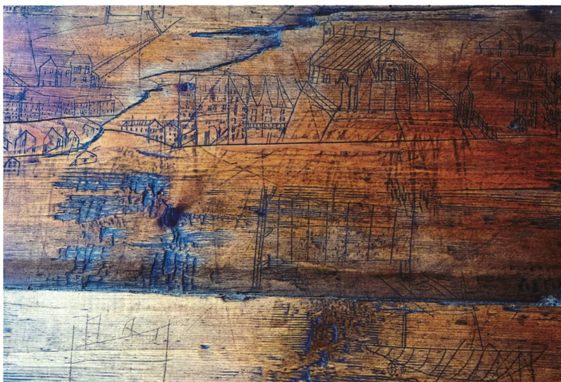
[21] Tomils, Casa Davos Sei n. 3, disegni di case ed edifici di mano ignota scoperti sotto il rivestimento in legno. Foto: ADG/SAG 2021
