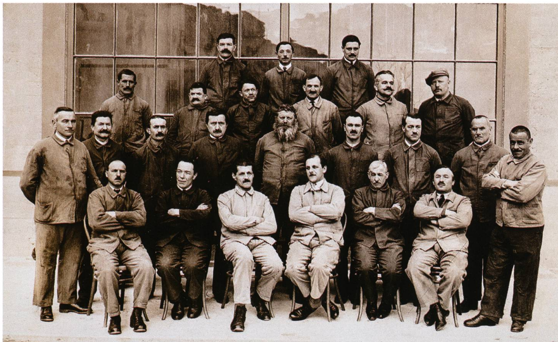
Personale della centrale di Campocologno, 1928. Fonte: Archivio Repower
