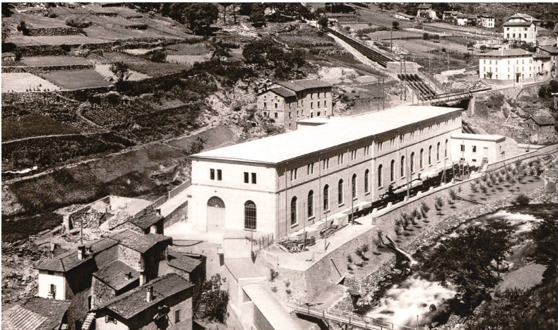
La centrale di Campocologno, 1906. Fonte: Archivio Repower
