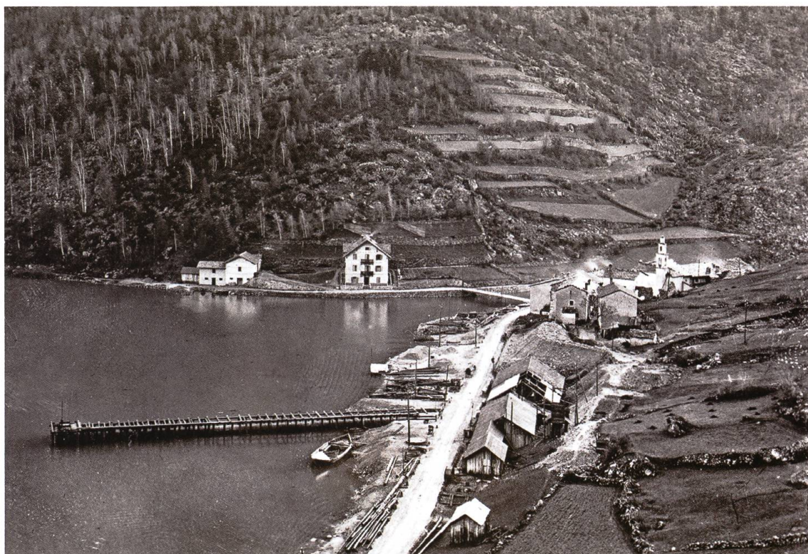
Presa d'acqua a Miralago, 1907 ca. Fonte: Archivio Repower
