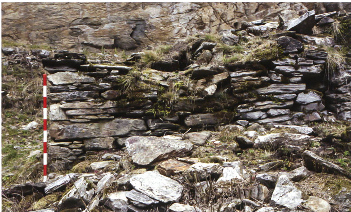
Scatta, fronte sud della struttura identificata a forno (fotografia Yolanda Alther).
