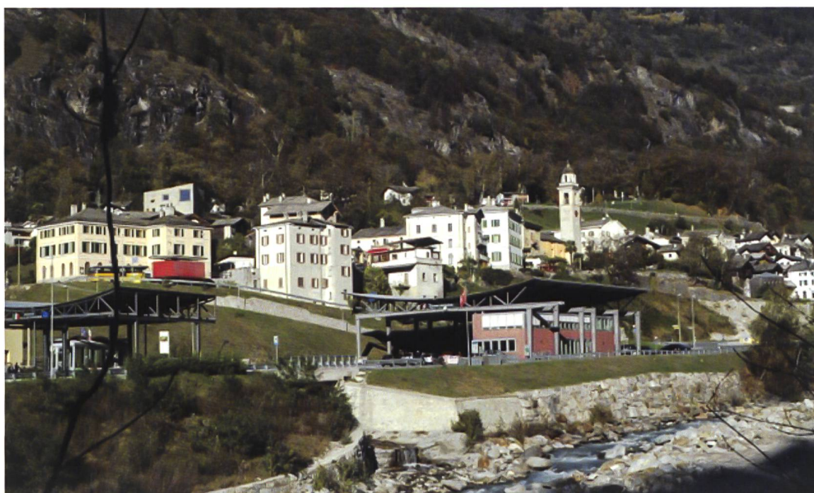
Sul confine, oggi
