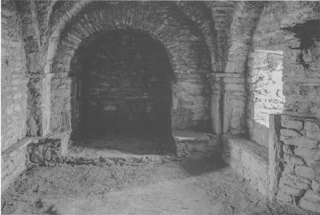
Figura 7: Castello di Santa Maria in Calanca. Piano superiore con accenni di volte, nicchie delle finestre e panche di pietra lungo le pareti (Johannes Meyer, Fotostiftung Graubünden).
