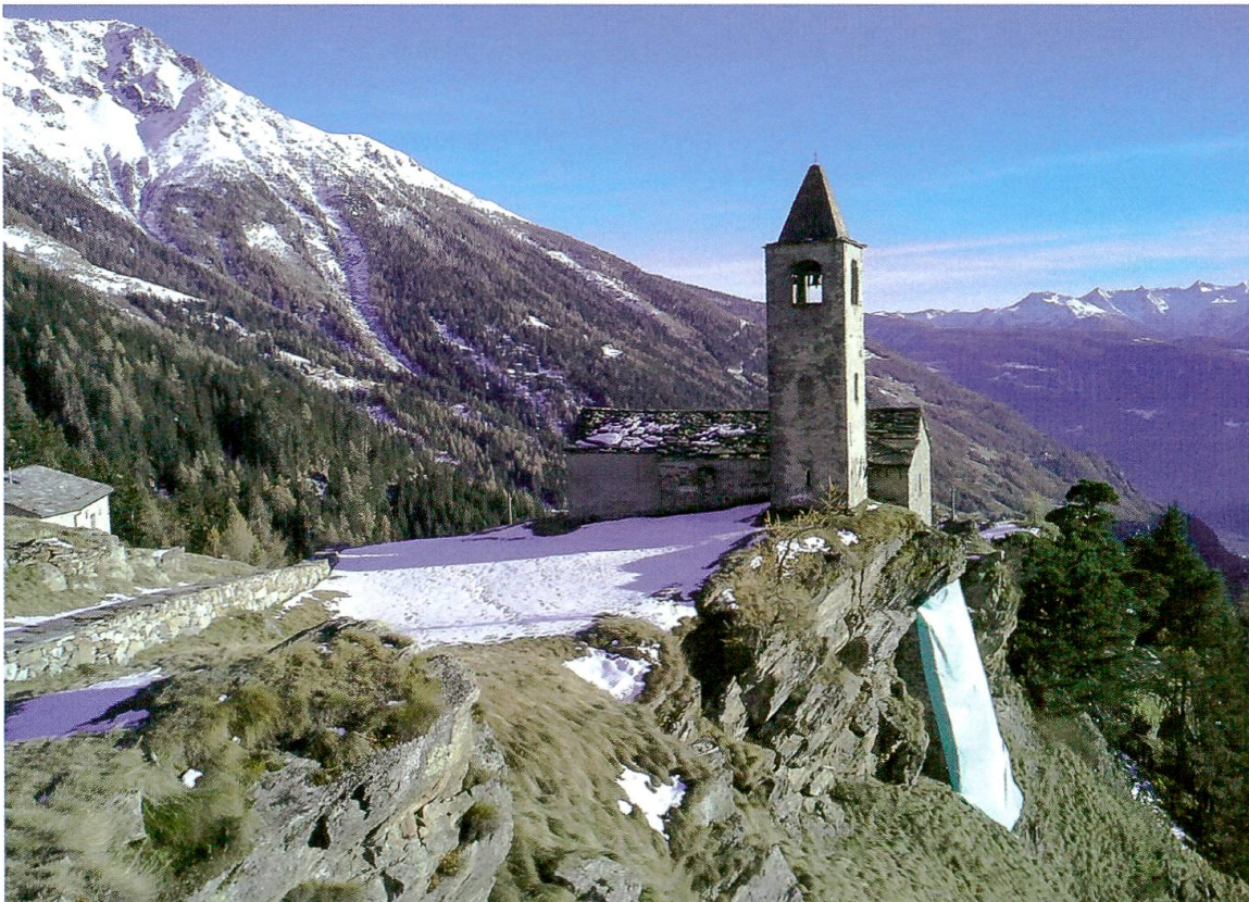
La posa del telo di protezione
