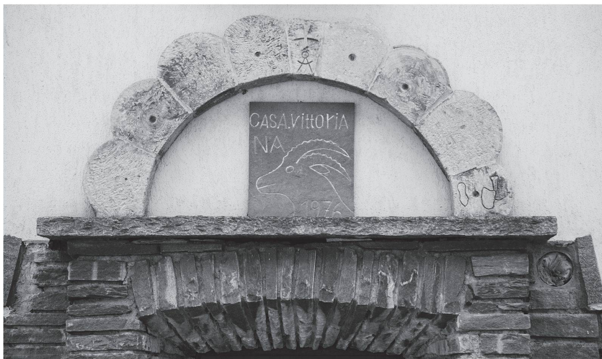
Figura 3: La volta B, oggi non più sull'edificio identificato dal Simonett, e ricomposta in ordine diverso da quello del 1964. Lo specchio delle pietre è decorato con cerchi concentrici o colpi di scalpello.
