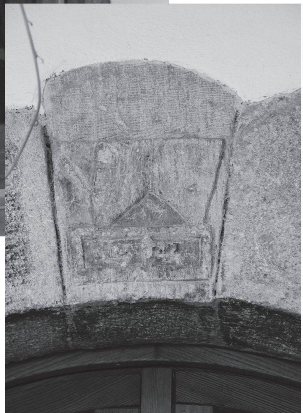
Figura 4 La volta C, non più nella posizione registrata dal Simonett, conserva una chiave di volta di difficile interpretazione. I restanti elementi hanno uno specchio picchiettato con bordi più lisci.
