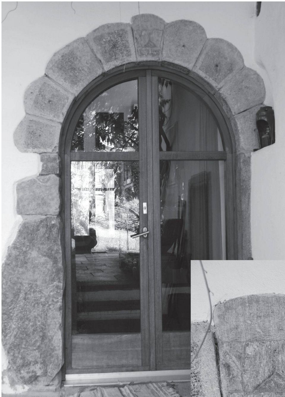
Figura 4 La volta C, non più nella posizione registrata dal Simonett, conserva una chiave di volta di difficile interpretazione. I restanti elementi hanno uno specchio picchiettato con bordi più lisci.
