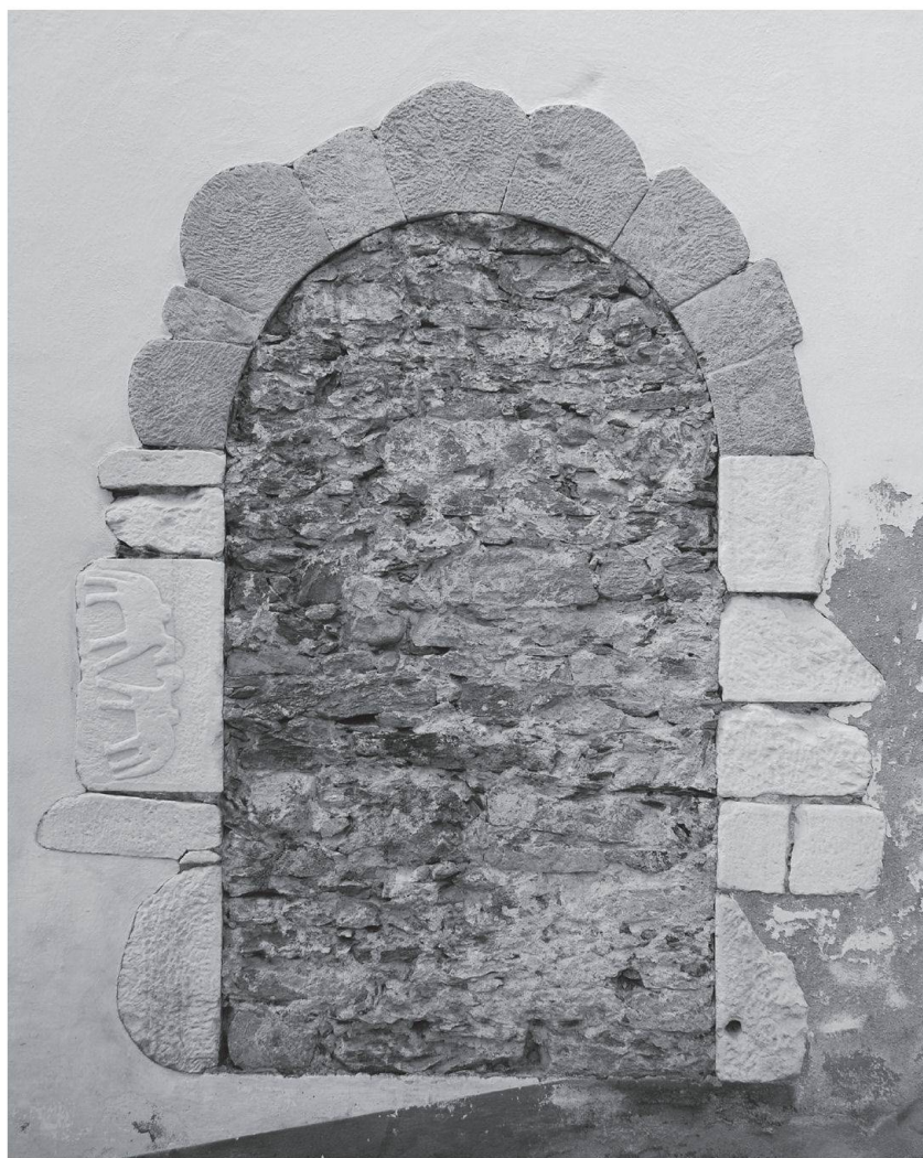
Figura 5: Volta ricostruita con vari elementi di riporto, tra cui, sulla sinistra, un elemento decorato in bassorilievo con due cavalli.
