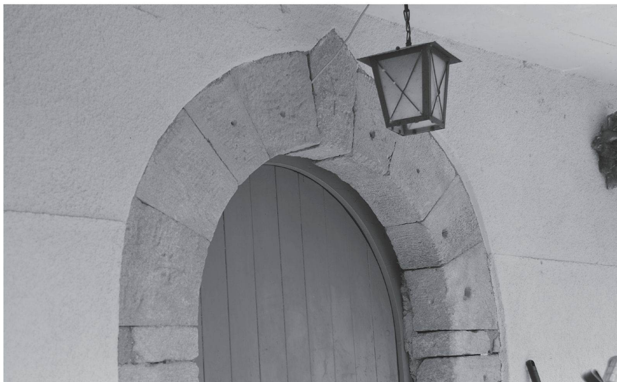
Figura 2: Volta A di Sozza, pressoché inalterata. La superficie è stata scalpellata con cura.
