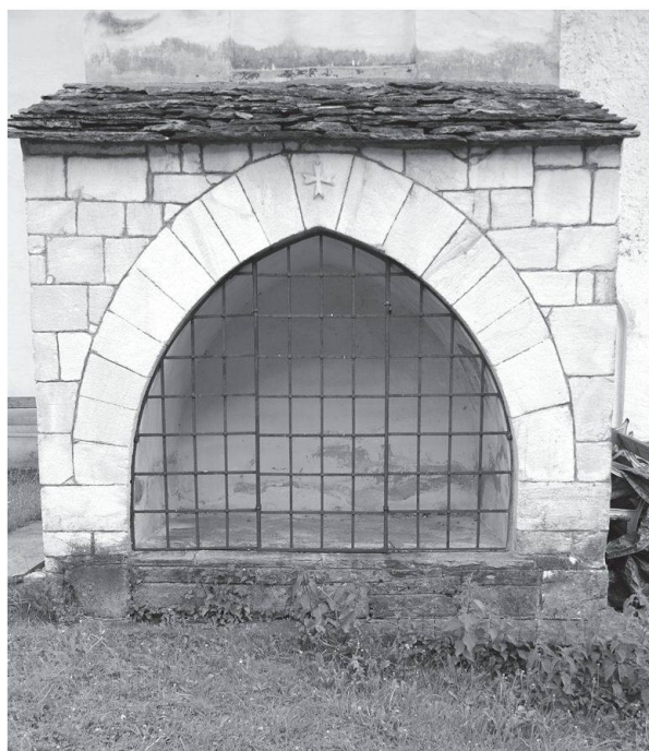
Figura 1: Addossata al campanile della chiesa la nicchia con una volta ad arco a sesto acuto con la chiave di volta ornata da una croce di Malta in bassorilievo.
