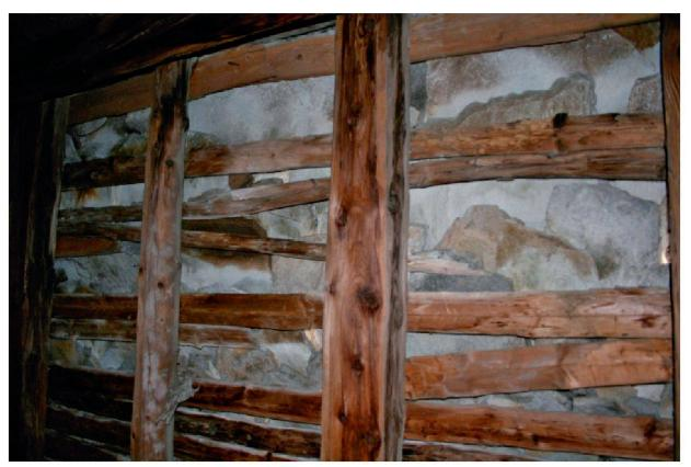
Nelle coperture mancano in diversi punti i sostegni delle piode causando un avvallamento del manto
