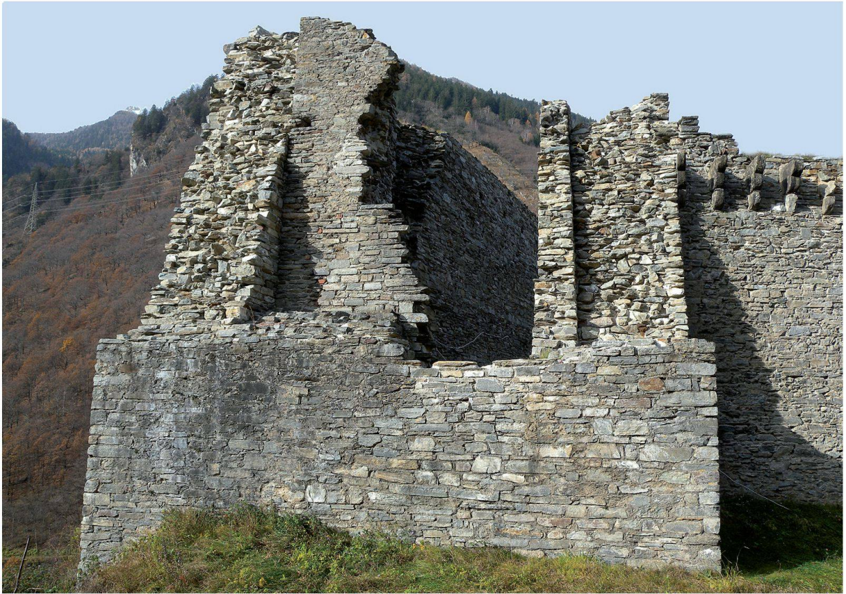
Ill. 20 - La torre sud eretta attorno al 1400 viene consolidata dopo il 1480 con costruzioni antemurali di uno spessore di 2 m, veduta verso nord-ovest (fotografia Servizio archeologico dei Grigioni)
