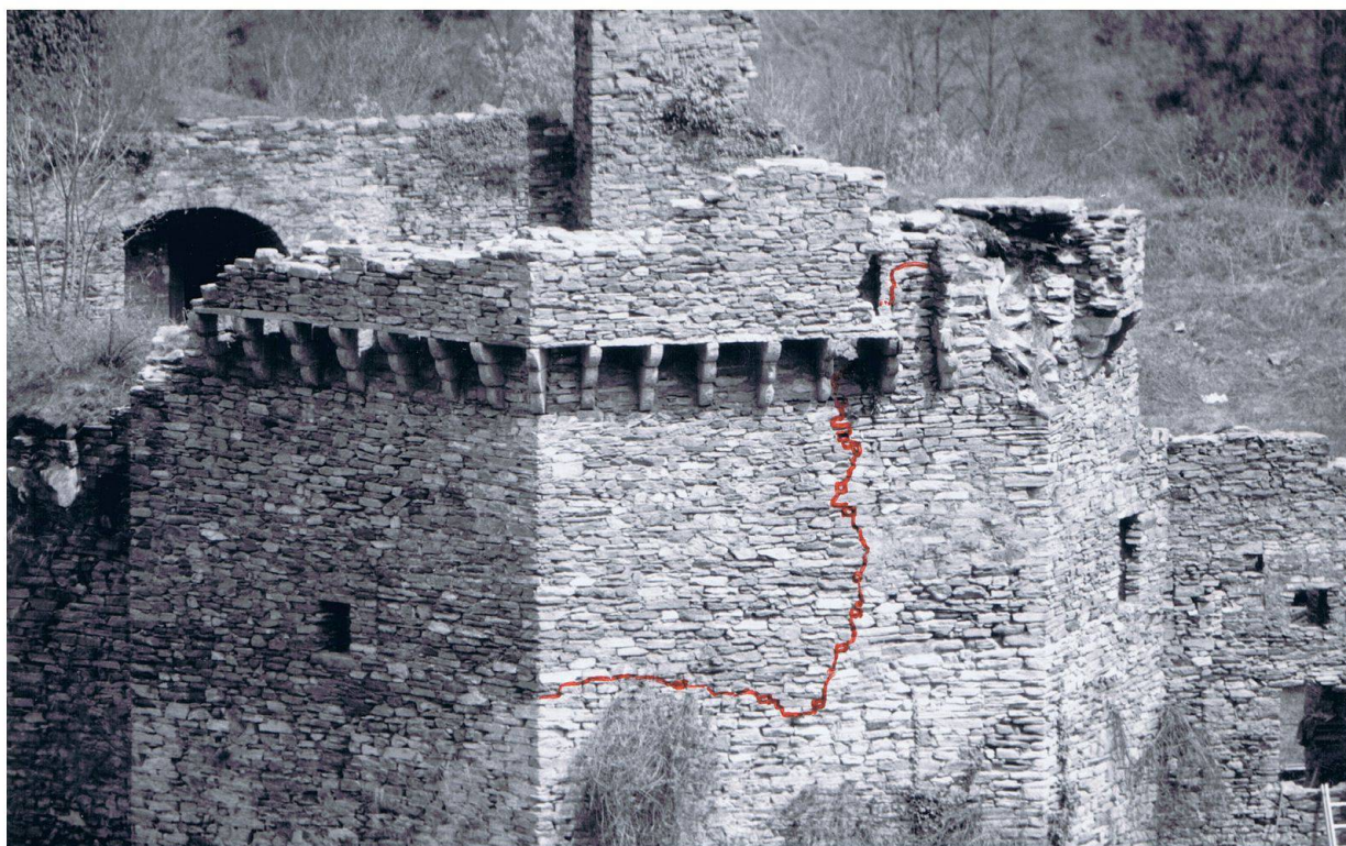
Ill. 1 - Castello di Mesocco, torre esagonale (1). Il residuo originale dopo la caduta dei beccatelli e del parapetto
