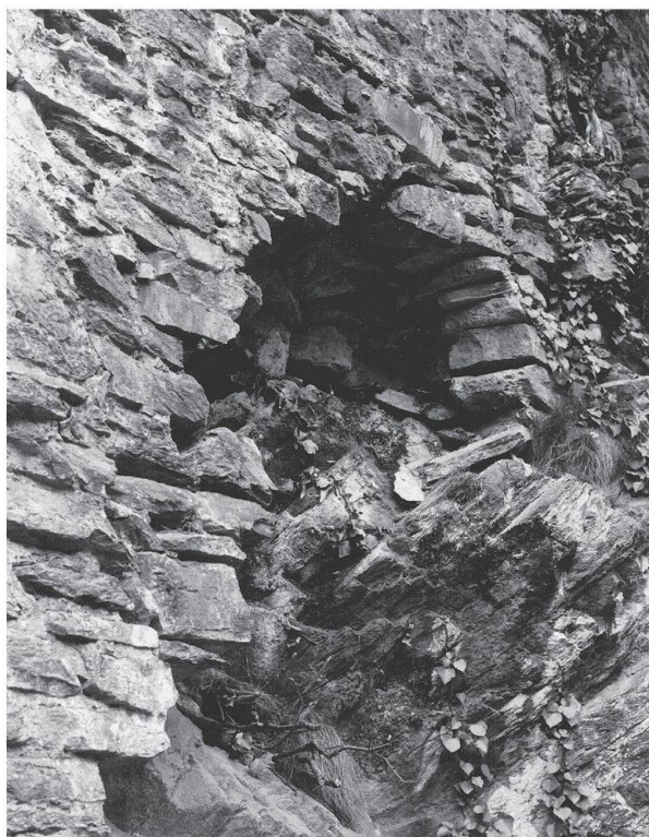
Ill. 2 - Castello di Mesocco. Guasti nella muratura e nel basamento roccioso della torre nord (3)
