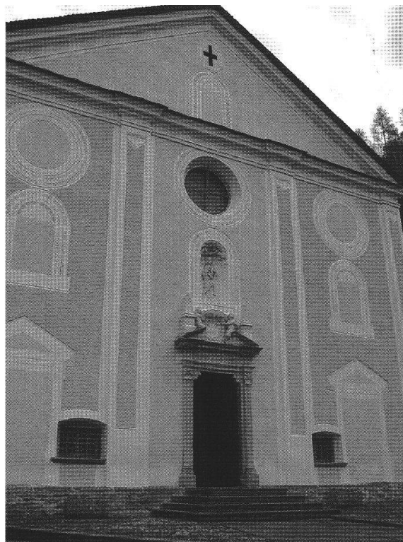
Facciata principale ad ovest della Chiesa della Madonna del Ponte Chiuso
