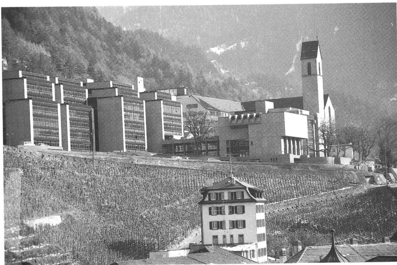
Il complesso della Scuola cantonale grigione alla Halde inaugurato nel 1973, architetto Max Kasper.
