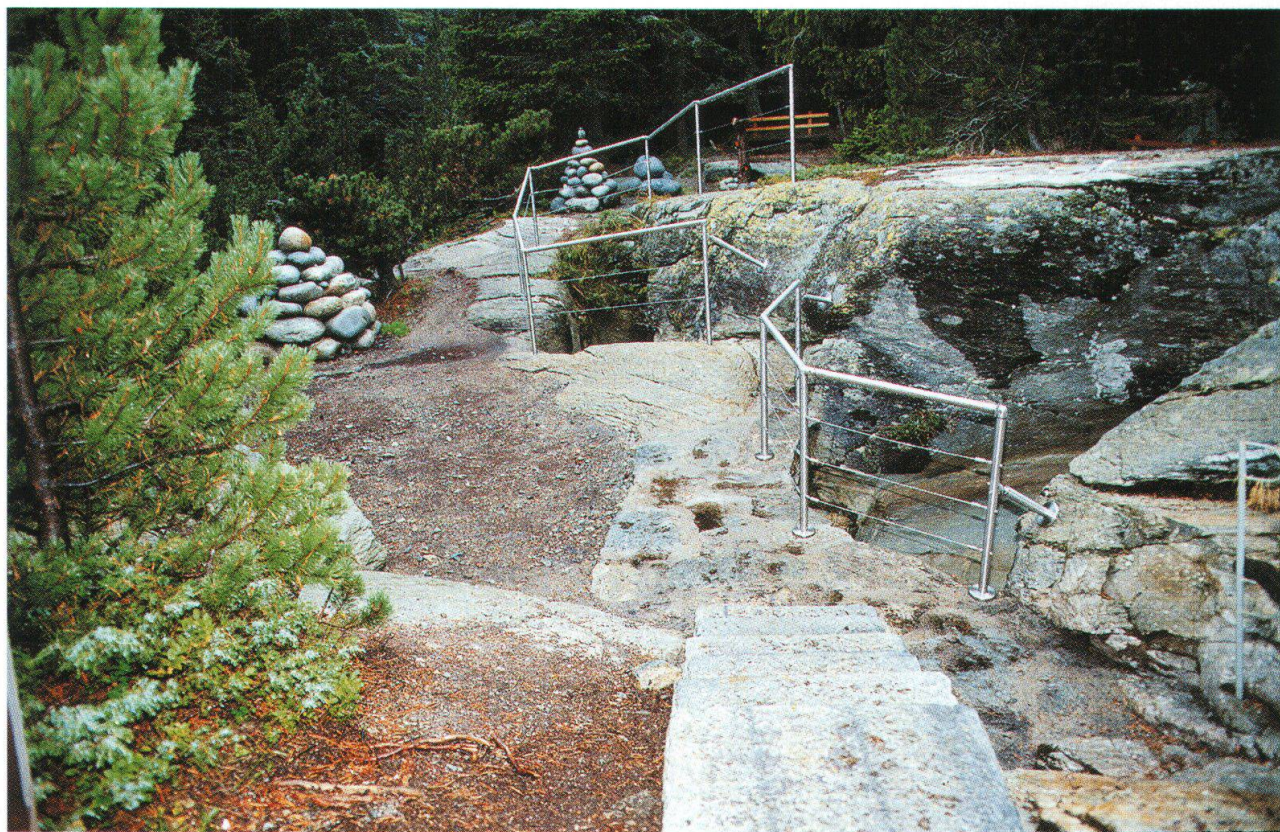
Un'apposita ringhiera in alluminio attorno alle marmitte, che si adatta perfettamente nell'ambiente naturale, è una necessaria protezione per evitare incidenti.
