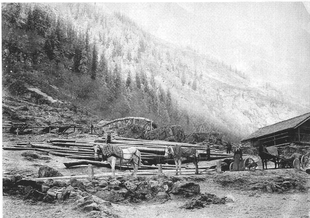
Carratori al lavoro a Pighé, frazione di Rossa, in una fotografia dei primi anni del Novecento. Qui la tecnica d'estrazione del legname si avvale di un cavo a sbalzo. Per superare il limitato dislivello, i tronchi venivano trainati con un sistema idraulico, visibile in secondo piano. Le installazioni e i boscaioli facevano riferimento al commerciante Arnoldo Papa
