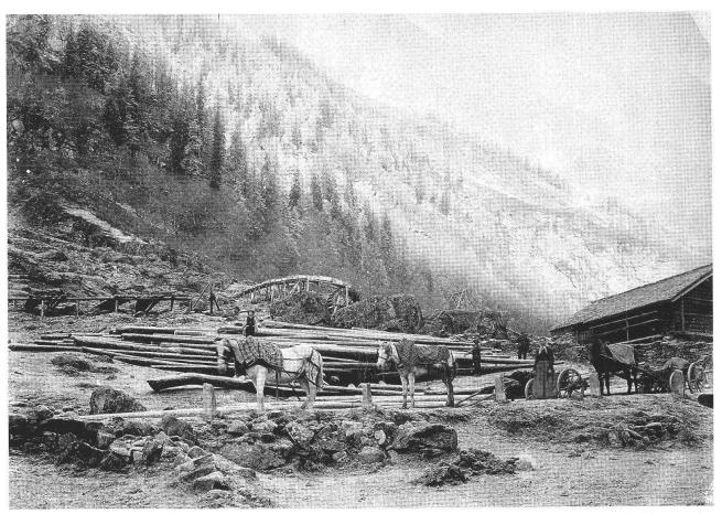
Carratori al lavoro a Pighé, frazione di Rossa, in una fotografia dei primi anni del Novecento. Qui la tecnica d'estrazione del legname si avvale di un cavo a sbalzo. Per superare il limitato dislivello, i tronchi venivano trainati con un sistema idraulico, visibile in secondo piano. Le istallazioni e i boscaioli facevano riferimento al commerciante Arnoldo Papa
