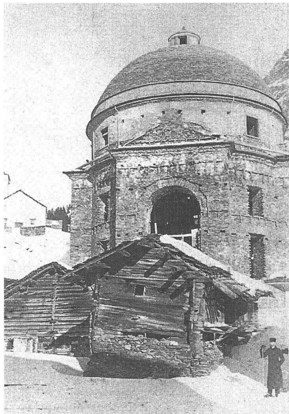
La nuova Chiesa di San Bernardino in costruzione
