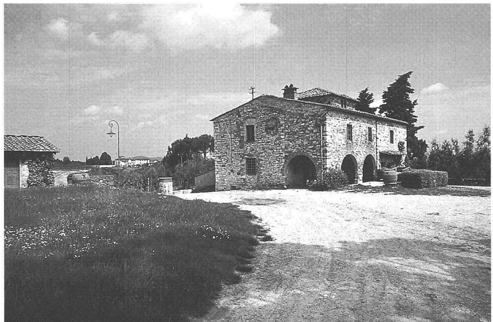
Tipica casa colonica con portico antistante e torre centrale
