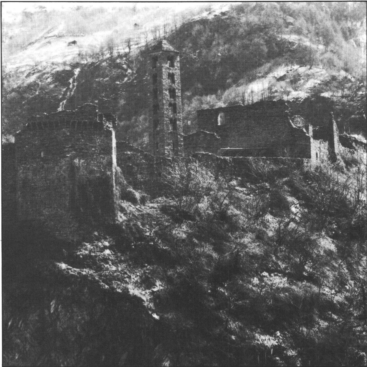
Veduta delle rovine da ovest: resti della torre poligonale con piombatoi, il campanile, resti della chiesa, della camerata e della cucina (Fot.: Zirpoli)
