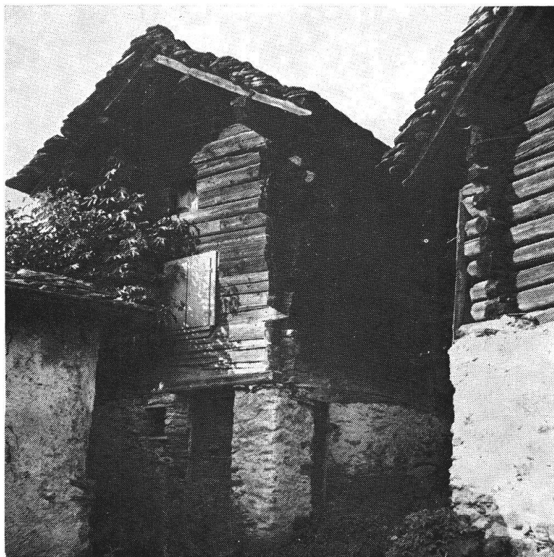
Una delle vecchie case demolite
