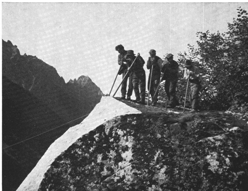
Un grosso masso di granito cede ai forti colpi di leva dei minatori.
