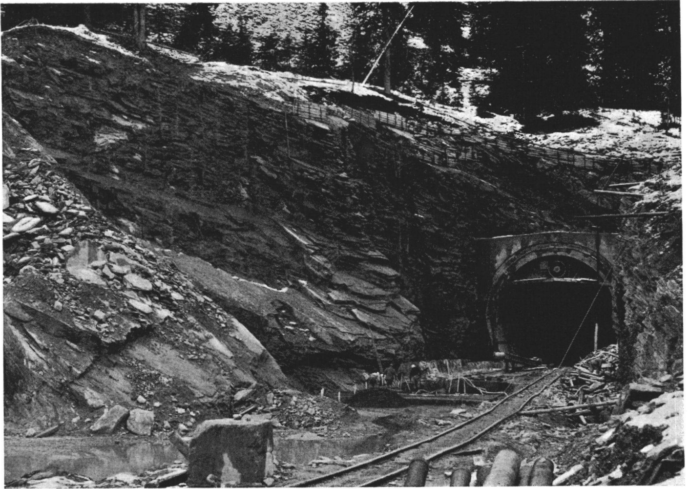
GALLERIA DEL SAN BERNARDINO, portale sud. I lavori di sgombero hanno messo allo scoperto la roccia in posto. L'inclinazione degli strati, immersi verso ovest, è di circa 45 gradi. La loro direzione che coincide con quella della galleria è nord-sud. La roccia è costituita da gneiss occhiadini della falda Adula.
