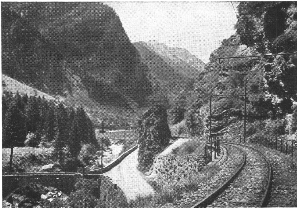
Ponte del Sasso sotto Soazza.
