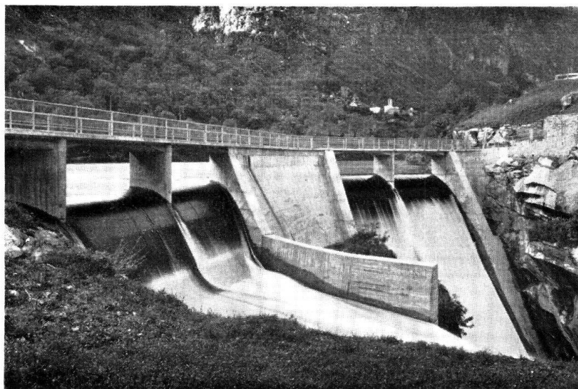
Diga del bacino di accumulazione di Molina, con sfioratori
