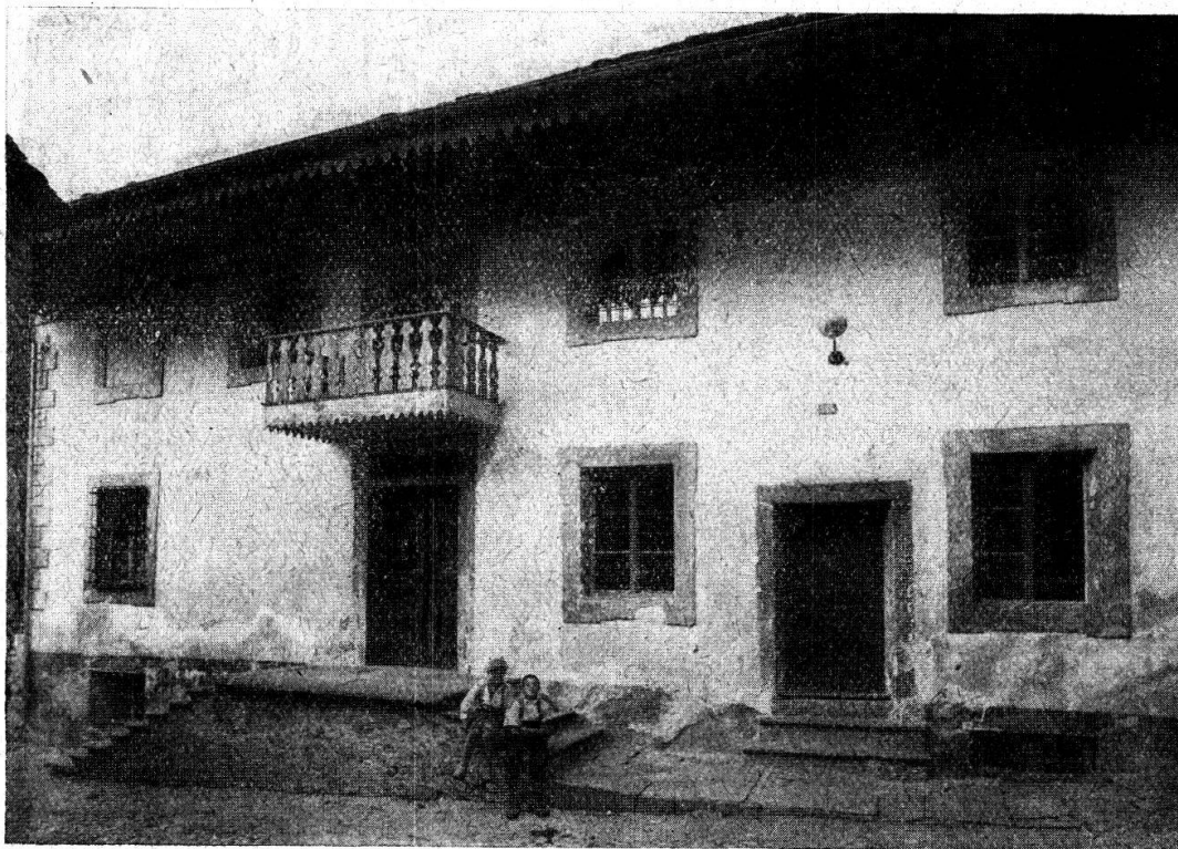
La Casa nuova di A. R., in seguito l'Ospizio dei Cappuccini, ora la Casa parrocchiale. (A destra l'entrata della Cappella).
