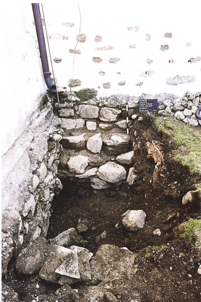
Abb. 197: Stufenweise Aufmauerung des Turmfundaments mit dem überlagernden Chorfundament der ref. Kirche St. Gallus in Fideris.
