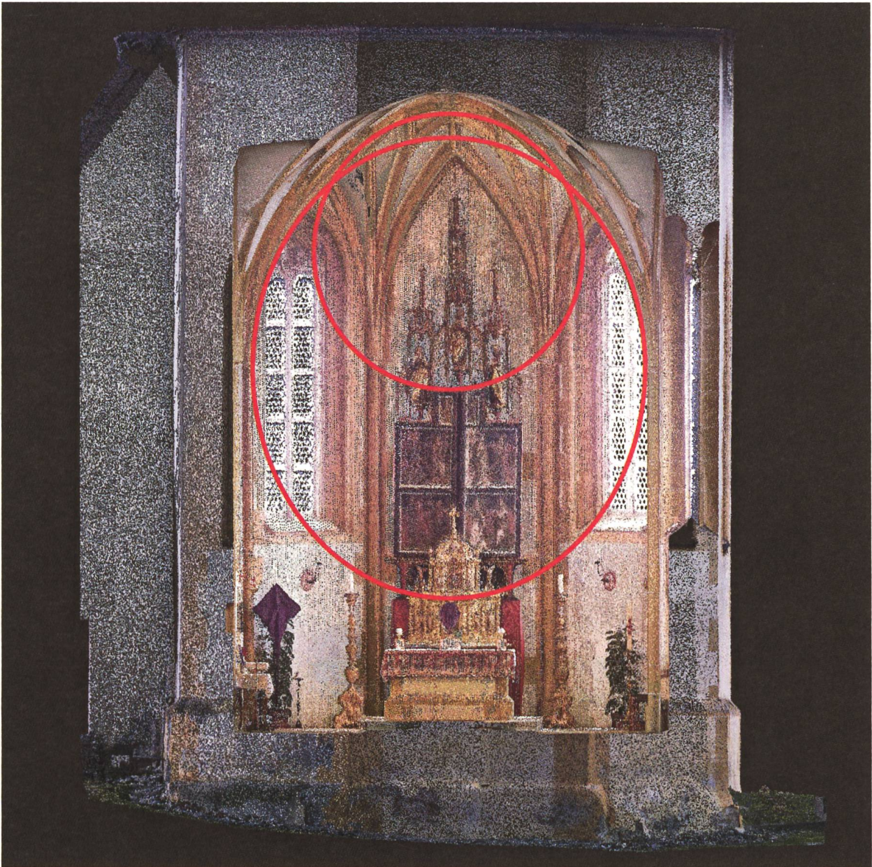
Abb. 194: Oval überhöhte Gewölbeform im Chor der Pfarrkirche St. Maria Magdalena in Stierva. Der Querschnitt wurde aus der Punktwolke eines Laserscans extrahiert (vgl. Abb. 181).
