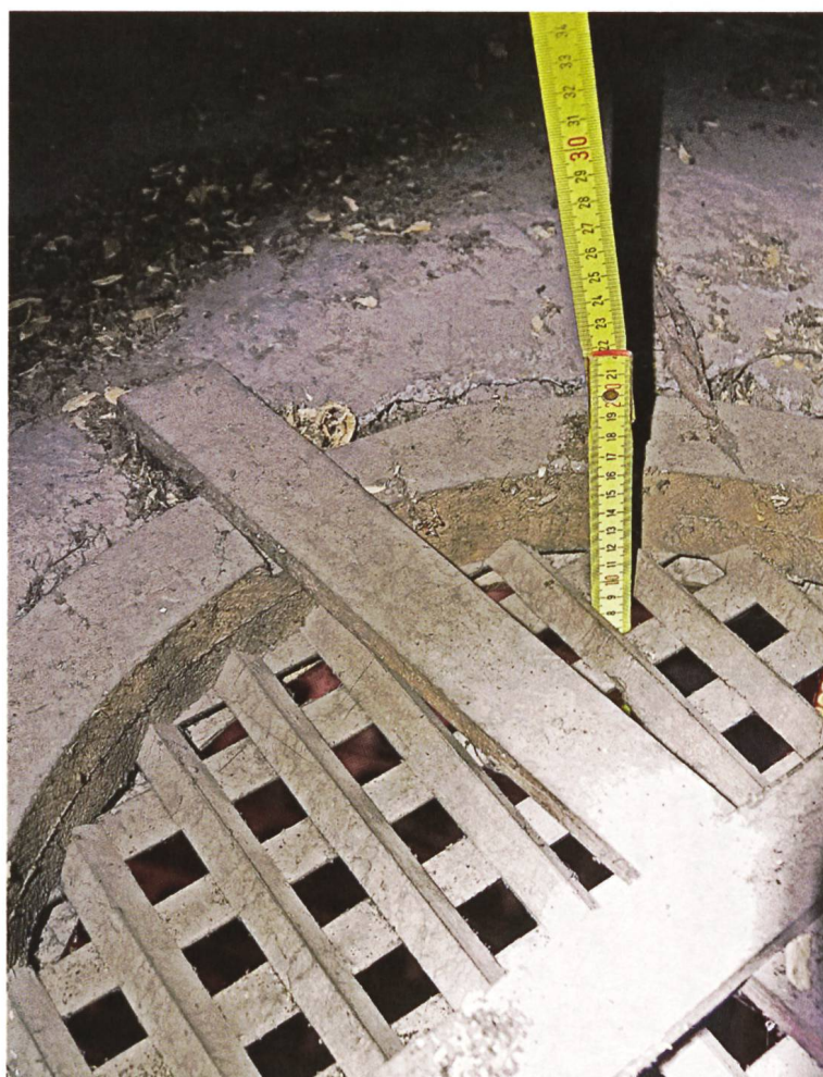
Abb. 186: Die Stärke des Langhausgewölbes an einem Heilgeistloch gemessen – die Stärke von 0.2 m wurde mit Messungen aus dem Innenraum der Kirche abgeglichen.
