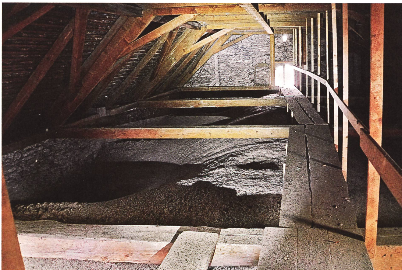
Abb. 104: Blick in den Dachstuhl der ref. Kirche von Thusis nach Westen mit Aussparungen der alten Dachkonstruktion in der Giebelwand.
