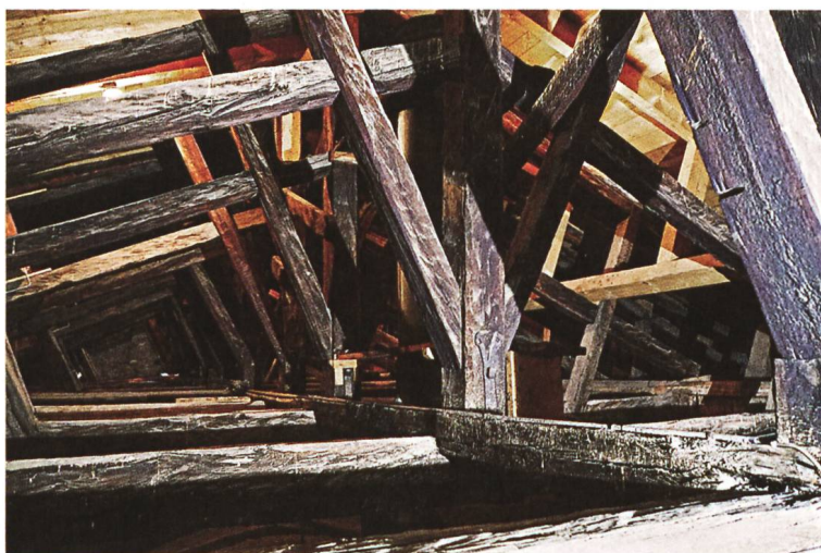
Abb. 138: Das flachgeneigte «italienische» Pfettendach mit mittlerer Hängesäule.
