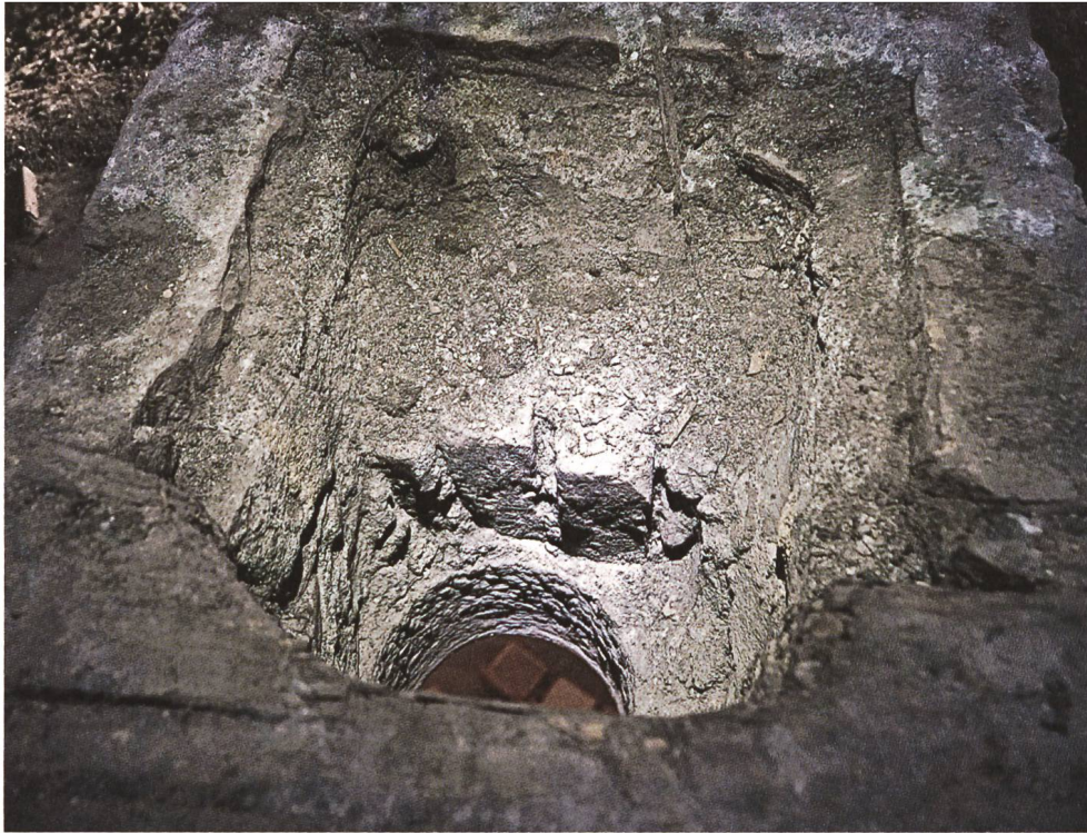
Abb. 124: Blick in das Heiligeistloch im Langhaus der Regulakirche: Die Backsteine verlaufen in einem regelmässigen Kufverband parallel zur Fläche der Gewölbekappen.
