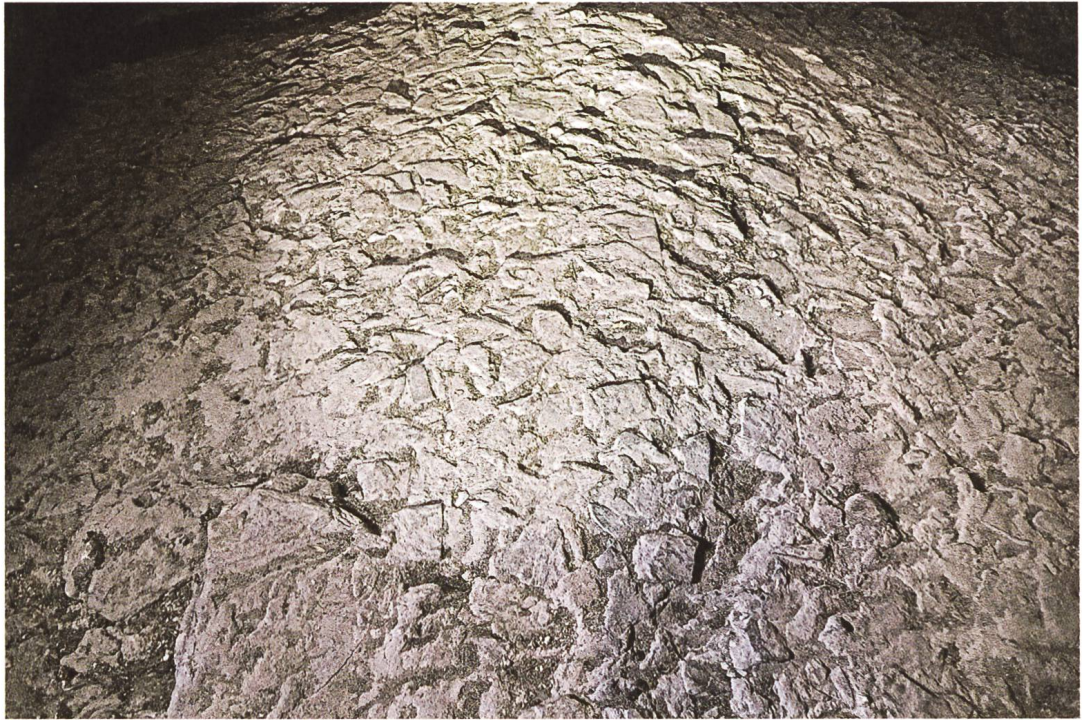
Abb. 133: Detailaufnahme des Extrados mit kleinen, in die Gewölbekappen gedrückten Schieferplatten.
