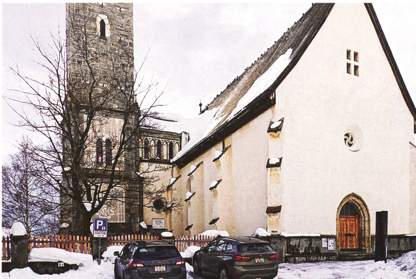
Abb. 99: Die Kirche San Lurench in Sent von aussen mit den abgesteppten Strebeböckeln, wie sie kurz darauf auch an der Stiftskirche von Poschiavo ausgeführt wurden.
