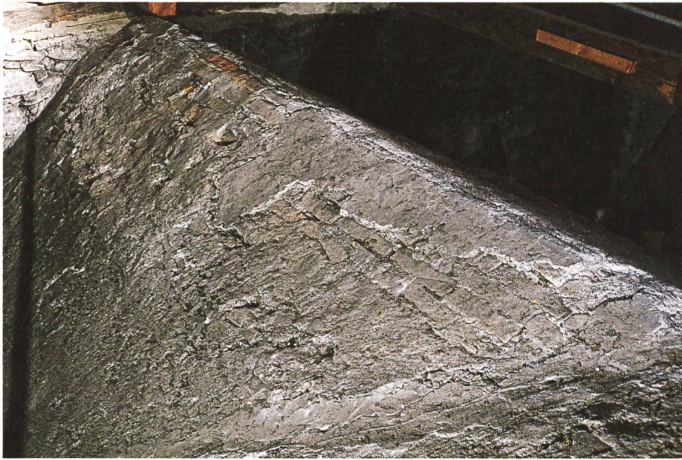
Abb. 59: Die Verwendung von Backsteinen im Gewölbe der Martinskirche lässt sich vom Dachraum aus an einigen wenigen Stellen ohne abschliessende Mörtelschicht gut erkennen, wie hier an einer der nördlichen Stichkappen im Langhaus.
