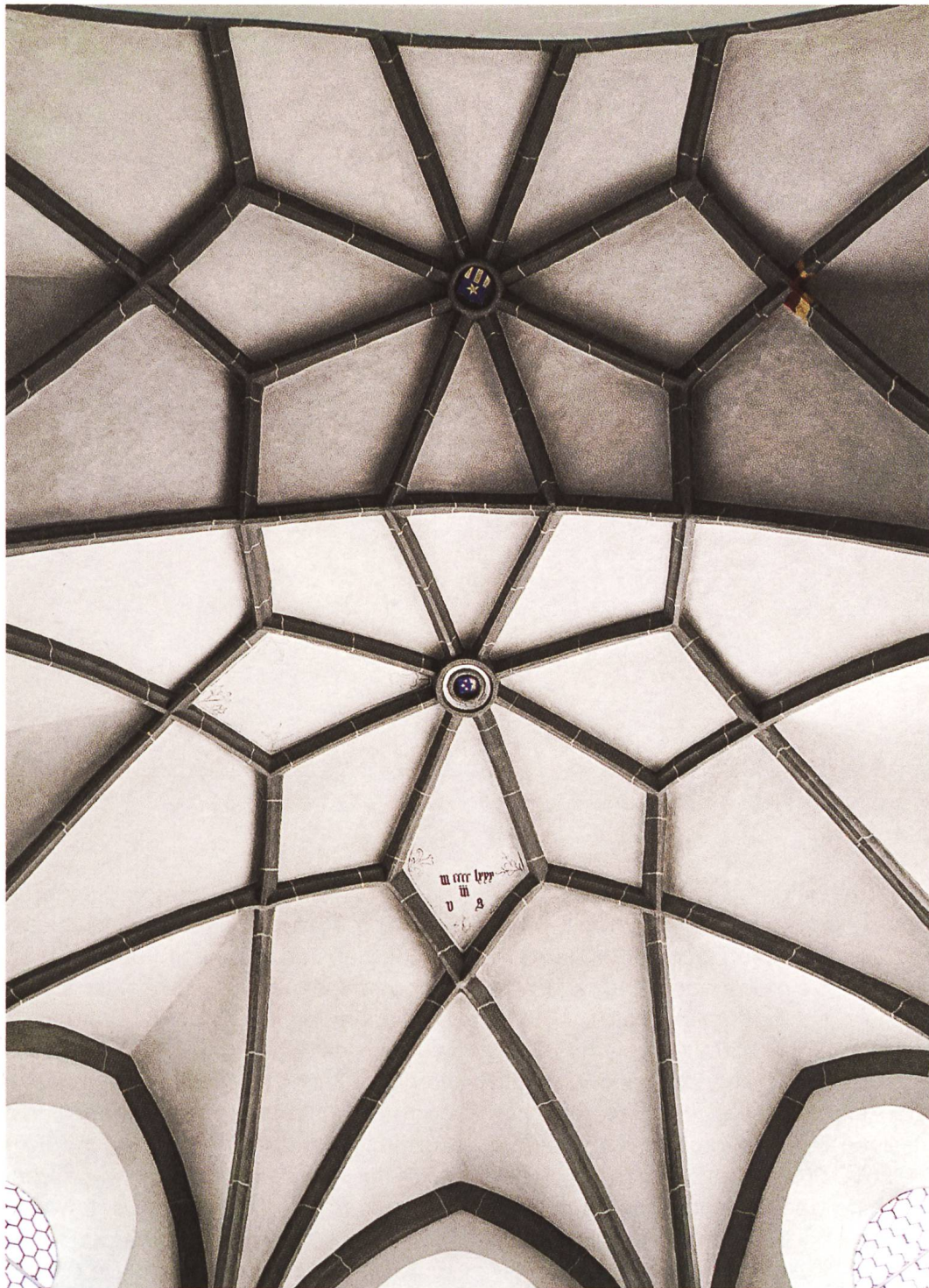
Abb. 70: Detailaufnahme des Haspelsterngewölbes im Chor der ref. Kirche von Jenaz mit Inschrift des unbekannten Baumeisters V. G.
