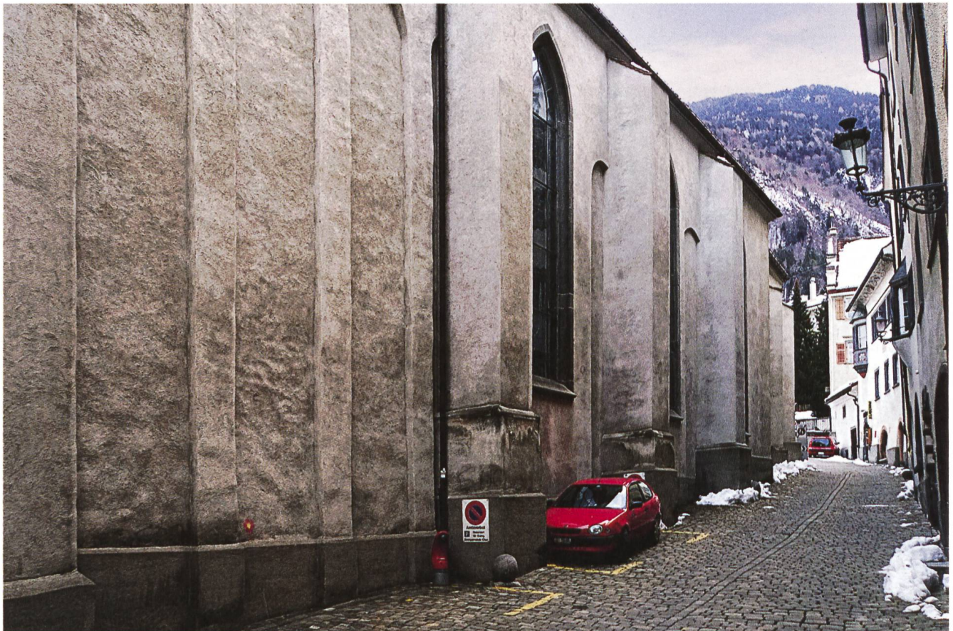
Abb. 50: Die Südwand der Martinskirche mit den noch sichtbaren karolingischen Blendarkaden.
