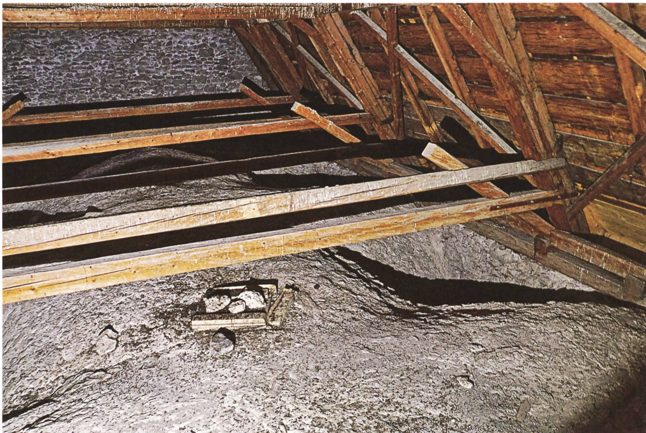
Abb. 65: Extrados der ref. Kirche Küblis mit massiven Bruchsteinkappen, die bis über die Schwelle der Dachkonstruktion reichen.
