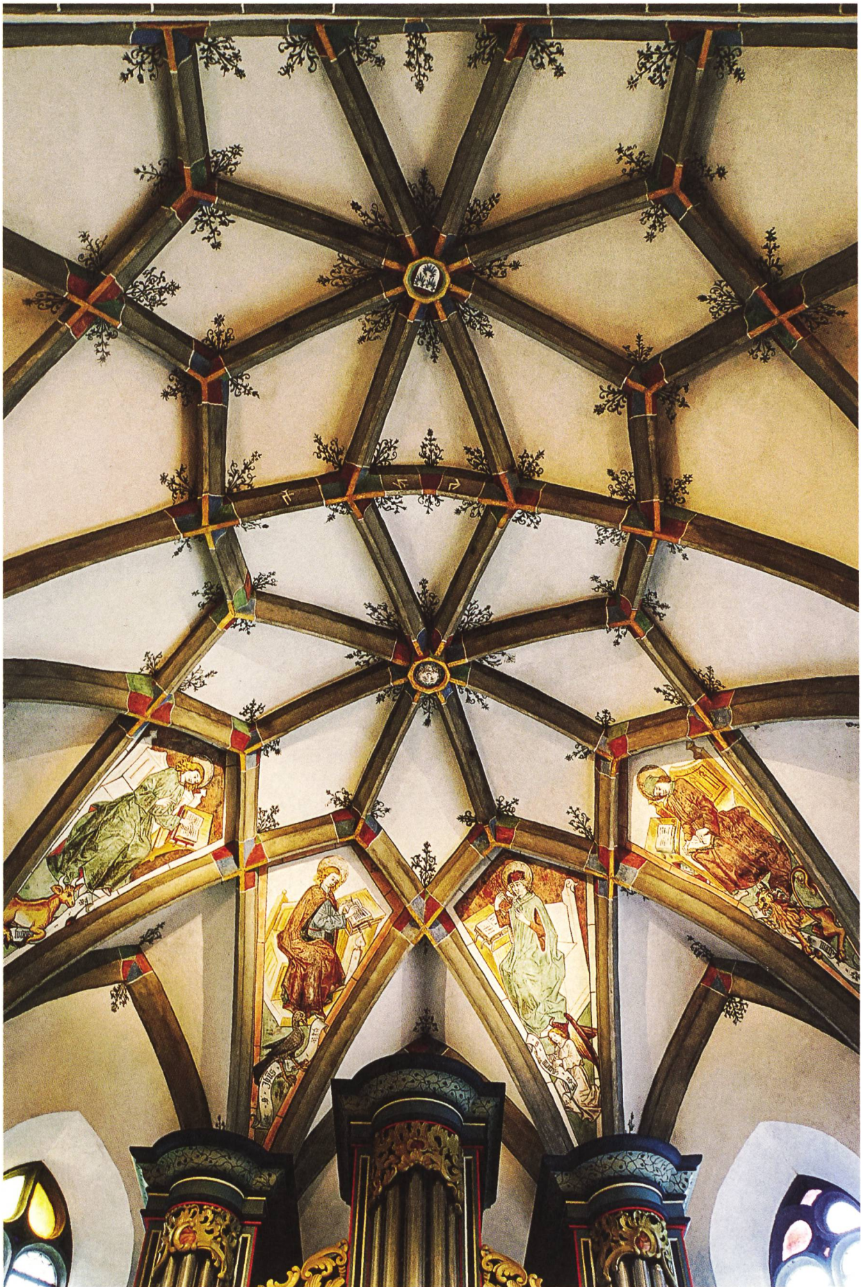
Abb. 68: Detailaufnahme des Haspelsterngewölbes im Chor der ref. Kirche von Luzein.
