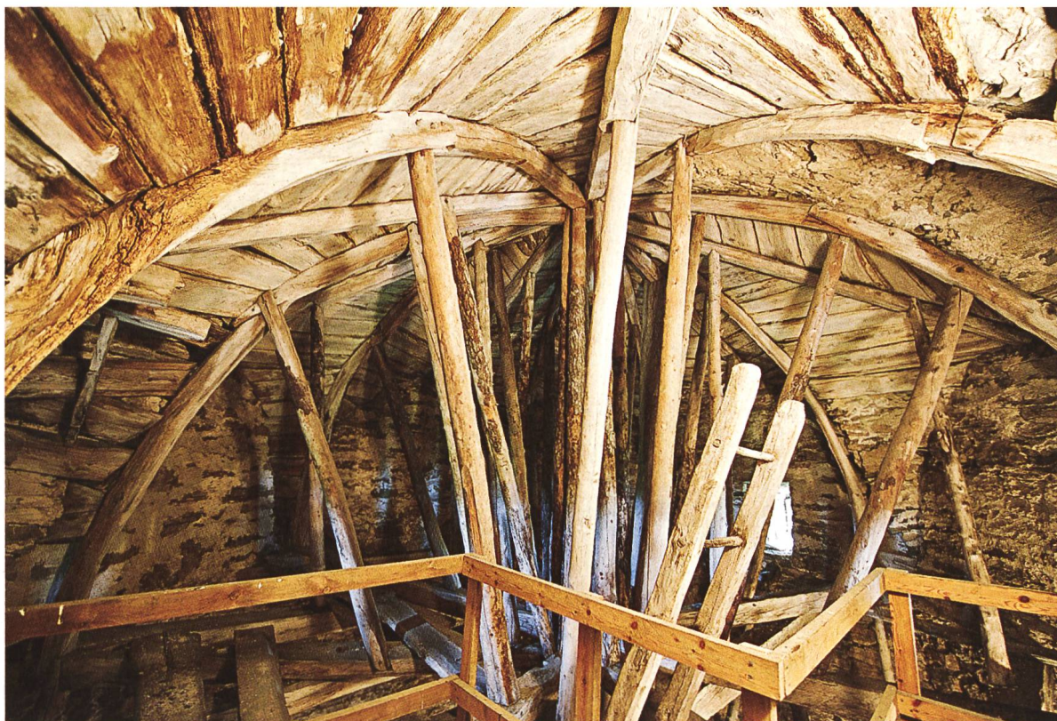
Abb. 28: Lehrgerüst, wohl aus dem 14. Jahrhundert, im Turm der Kirche von Lärbro auf Gotland (Schweden).
