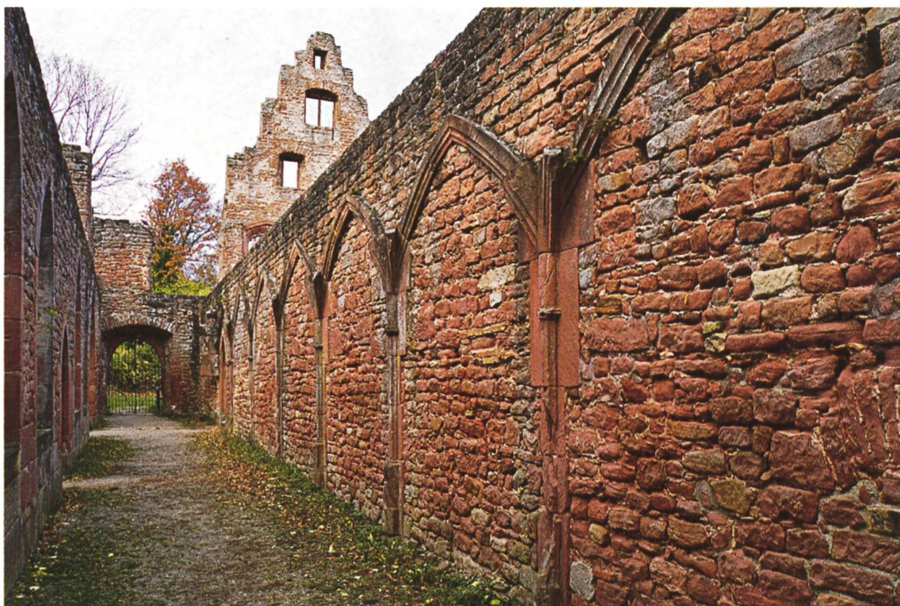
Abb. 29: In die Seitenwände einbindende Schildrippen im Kreuzgang der Klosterruine Limburg an der Haardt.
