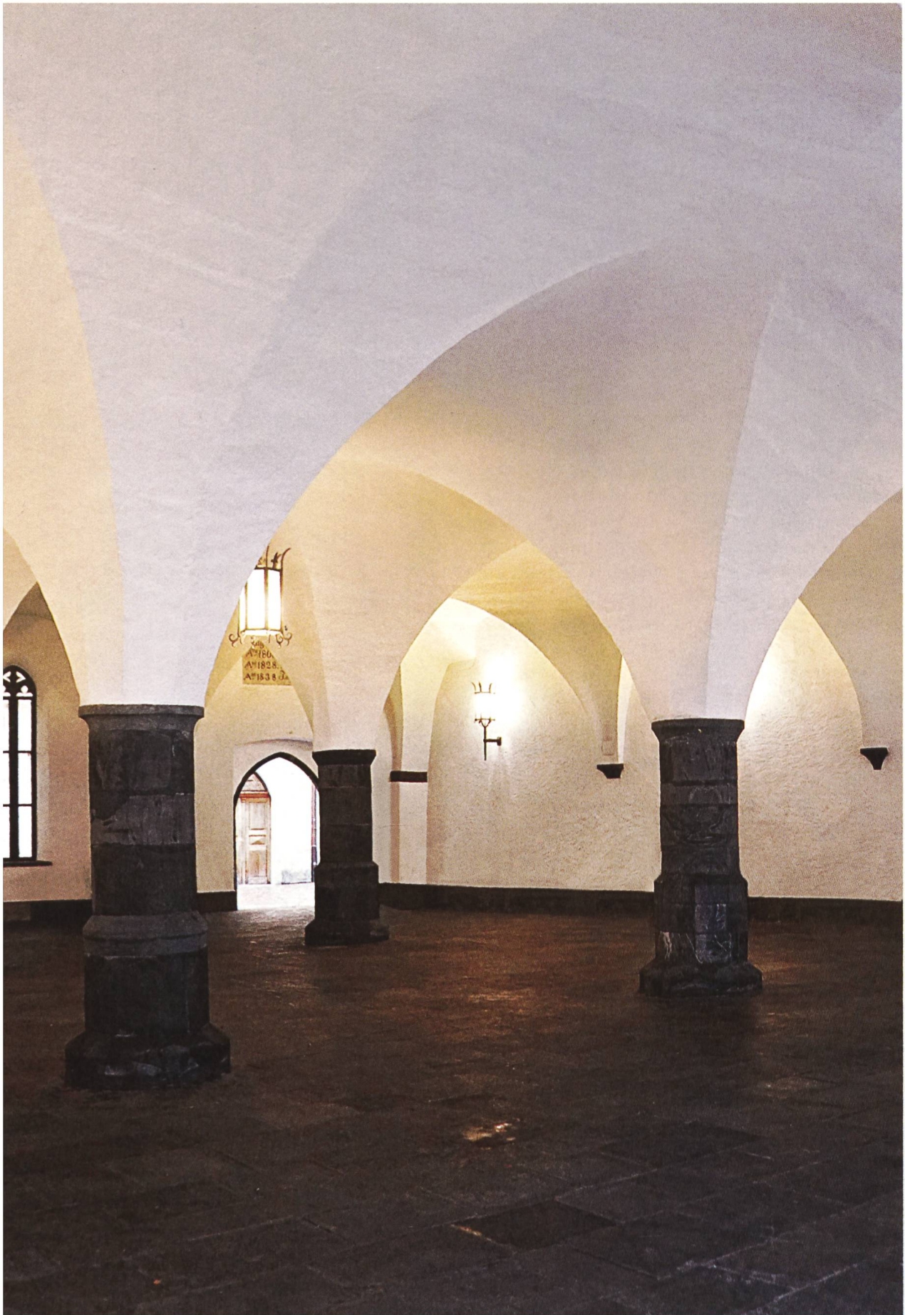
Abb. 33: Abdrücke von Schalungsbrettern in der Halle des Rathauses in Chur.
