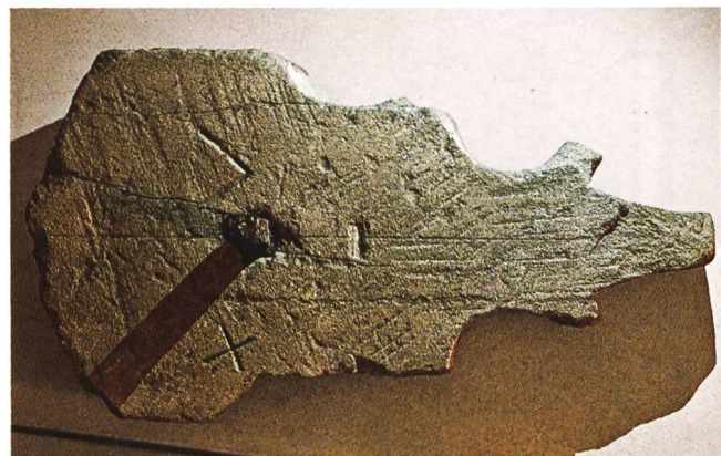
Abb. 32: Kurzes Rippenteilstück mit Bleidübel im Lapidarium der Stiftsbibliothek St. Gallen.
