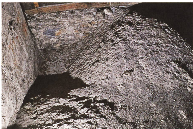
Abb. 34: Bruchsteingewölbe in der ref. Kirche von Küblis, Blick aus dem Dachraum in den südöstlichen Zwickel am Chorbogen.
