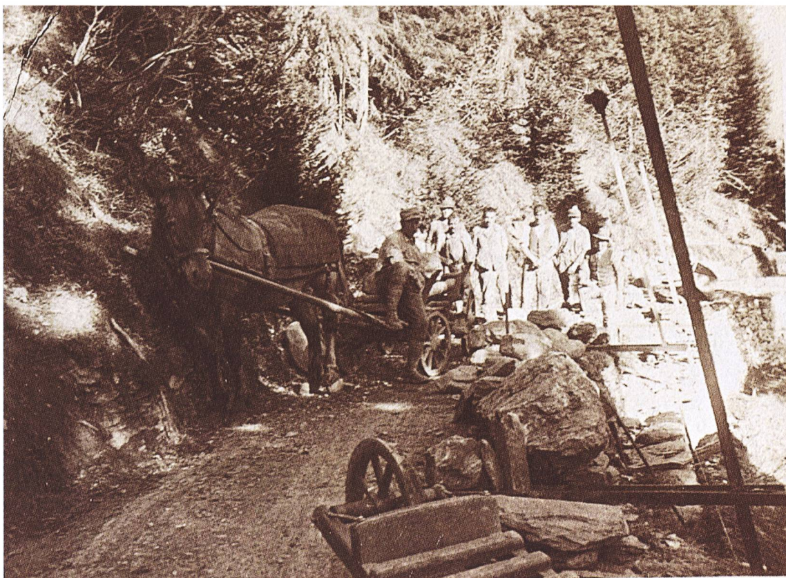
Abbildung 17: Strassenausbau an der Safienstrasse. Der Strassenbau blieb bis Mitte des 20. Jahrhunderts im Wesentlichen arbeits- und damit auch kostenaufwendige Handarbeit. Für die Materialtransporte wurden immer noch Pferdefuhrwerke verwendet.
