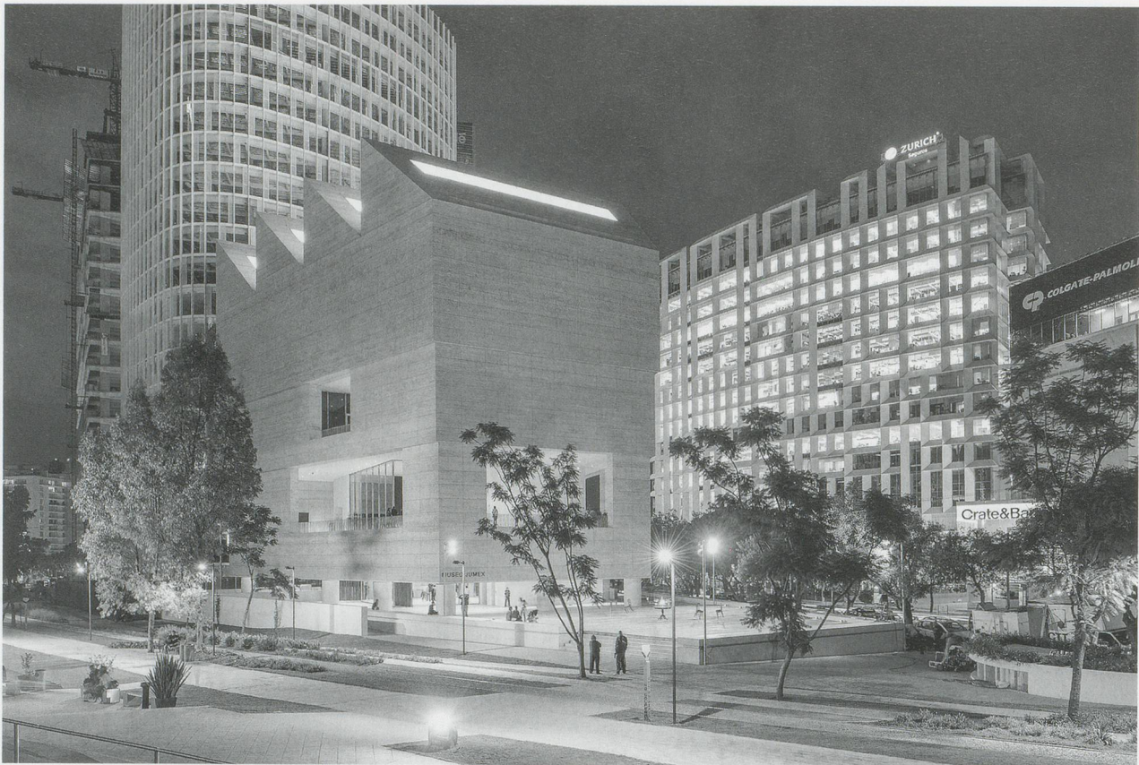
Museo Jumex, exterior view / Aussenansicht. (PHOTO: MORITZ BERNOULLY / COURTESY OF FUNDACIÓN JUMEX ARTE CONTEMPORANEO)
