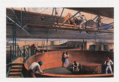
Coiling the cable in large tanks at the works in Greenwich / Aufwickeln des Kabels in grosse Behälter im Werk in Greenwich.
