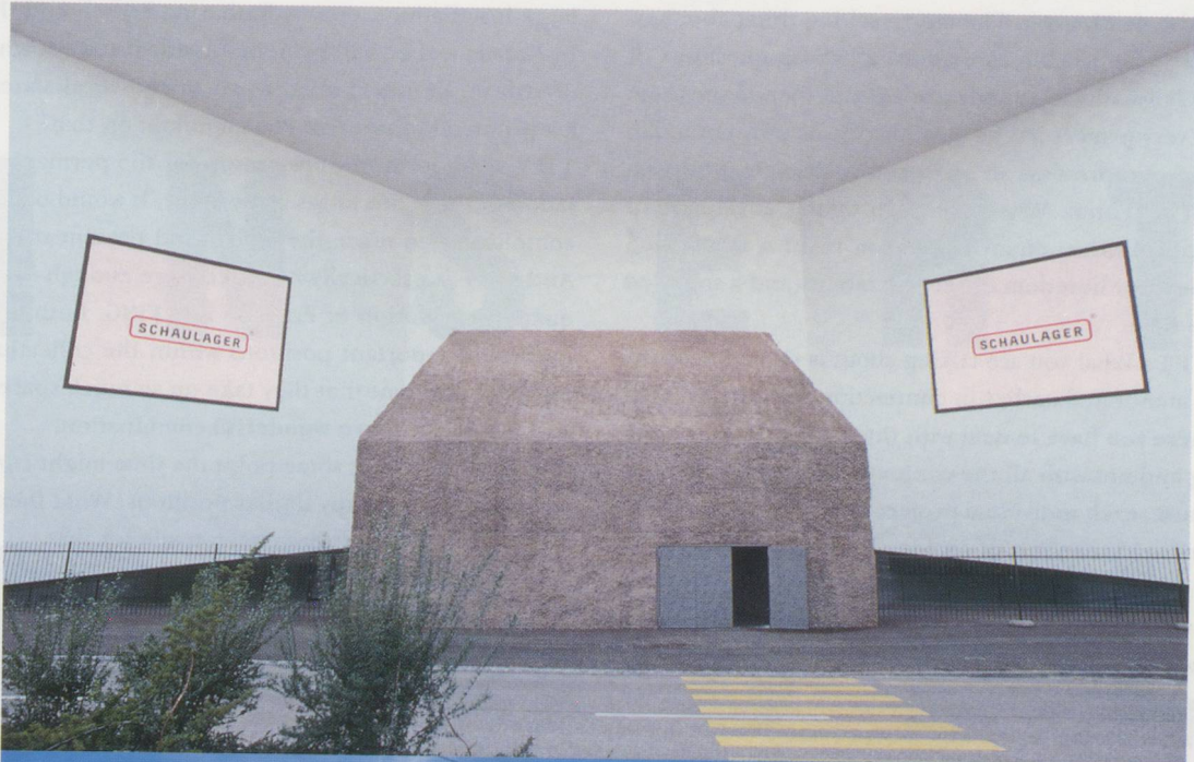
Blick auf den Eingangsbereich mit weiss lackierter Stahlfassade, LED-Screens und Torhaus / View of entrance zone with white laquered steel façade, LED screens, and gatehouse. (PHOTOS: ADRIAN FRITSCHE, ZÜRICH)
