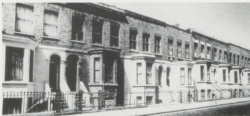
Grove Road early 1980s / Grove Road in den frühen 80er Jahren. (PHOTO: ARTANGEL)
