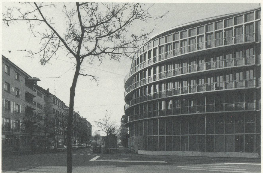
HERZOG & DE MEURON IN COLLABORATION WITH ANNETTE GIGON, WOHN- UND GESCHÄFTS- HAUS «SCHWITTER» / APARTMENT AND OFFICE BLOCK «SCHWITTER», BASEL, 1985–88.
