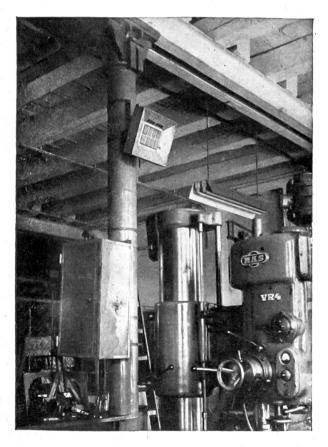
Abb. 1. Beheizung einer Werkstätte durch Schrägstrahler. Trotz der kalten Luft haben die im Strahlungsbereich befindlichen Personen das Gefühl der Wärme
