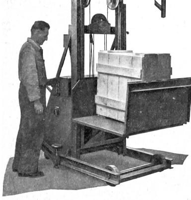
Fahrbarer Hubstapler mit ausziehbarem Gerüst, so daß die Hubhöhe wesentlich erhöht werden kann. Der Antrieb erfolgt durch einen Elektromotor
