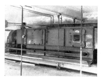
Abb. 4. Kleineres Klimagerät in Stahlblechausführung (Horizontalanordnung)
